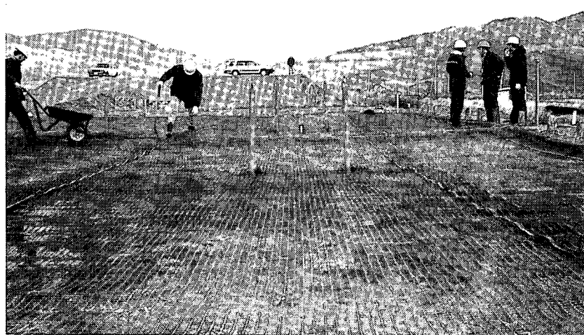
写真-5.3 沈下計設置状況
