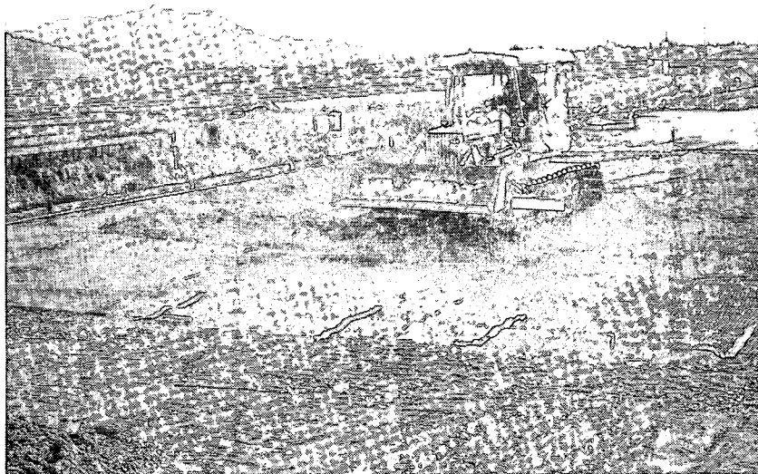
写真-5.7 盛土施工状況 (その2)
