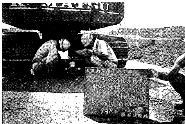
写真-4.10 平板載荷試験
