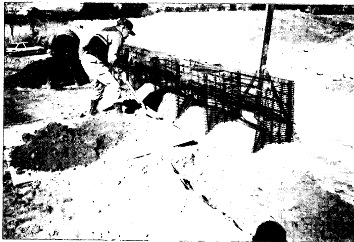
写真-6.1.2 Type-1のソイルセメント 投入状況
