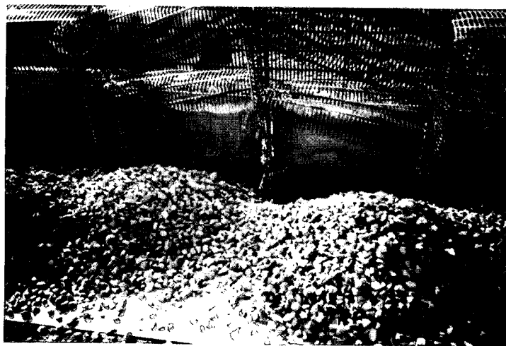
写真-6.1.3 Type-2の碎石 投入状況
