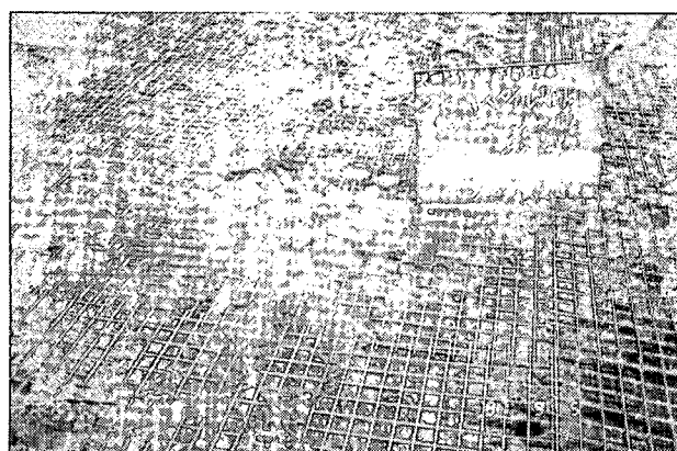
写真一 6 Steel (溶接金網) 敷設状況 (Case-C)
