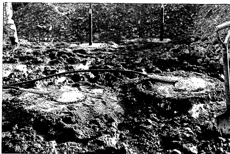
写真-4.3 土圧計設置状況
