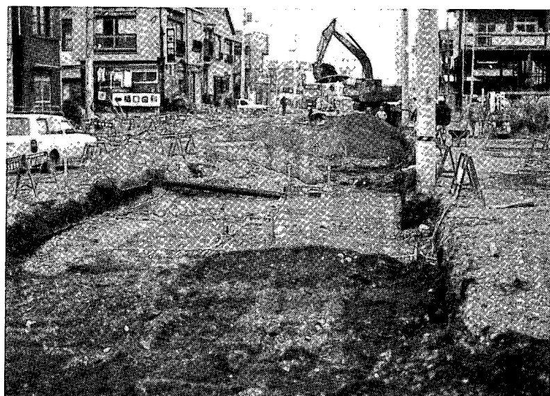
写真-4.4 試験工区施工状況
