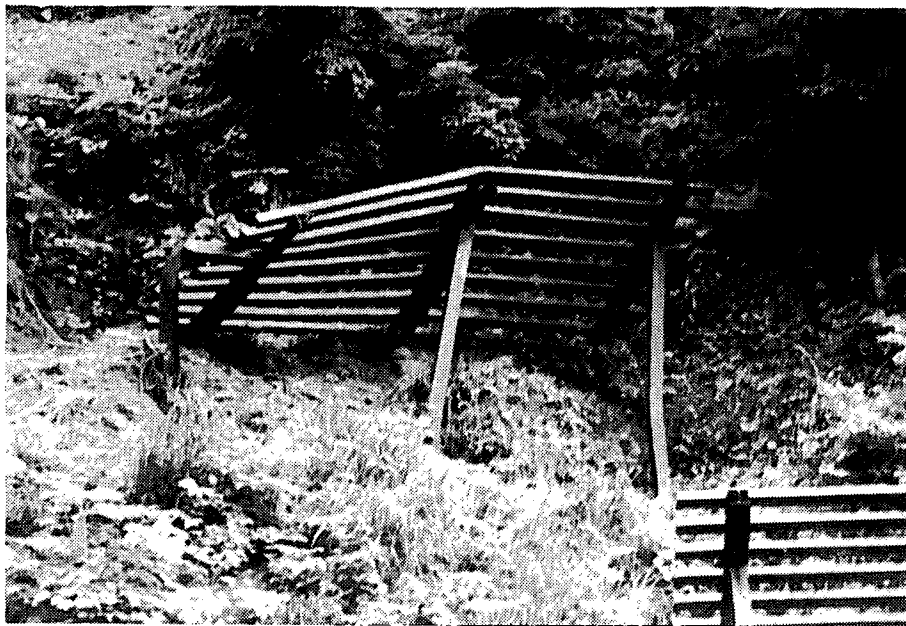
落石や流木の衝突が 原因と思われるバー および支柱の変形
