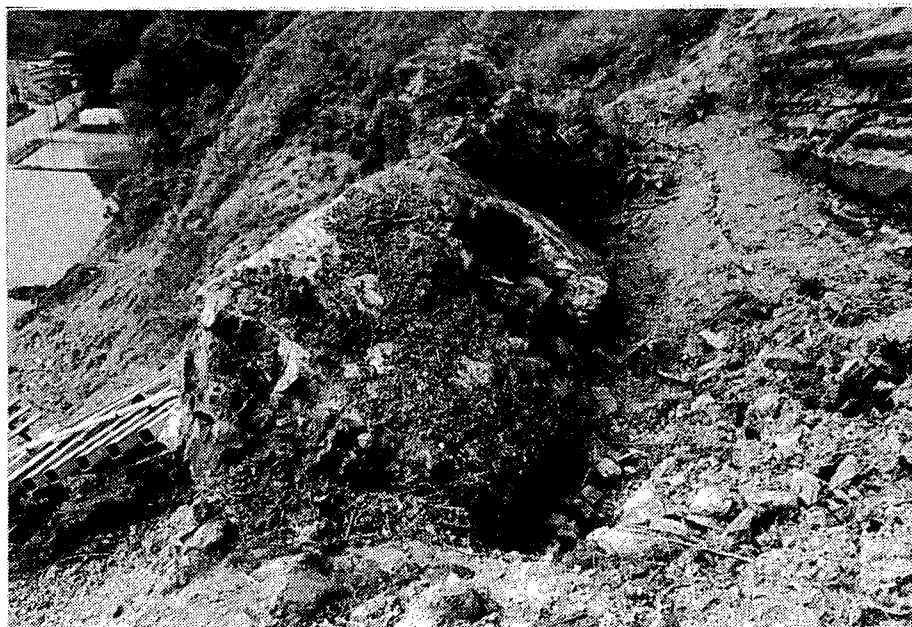
写真-3.7 基礎の転倒
