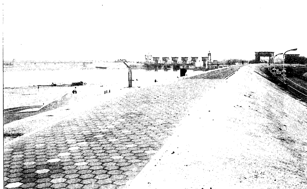
写真 4.6.2 堤防の盛土の例
