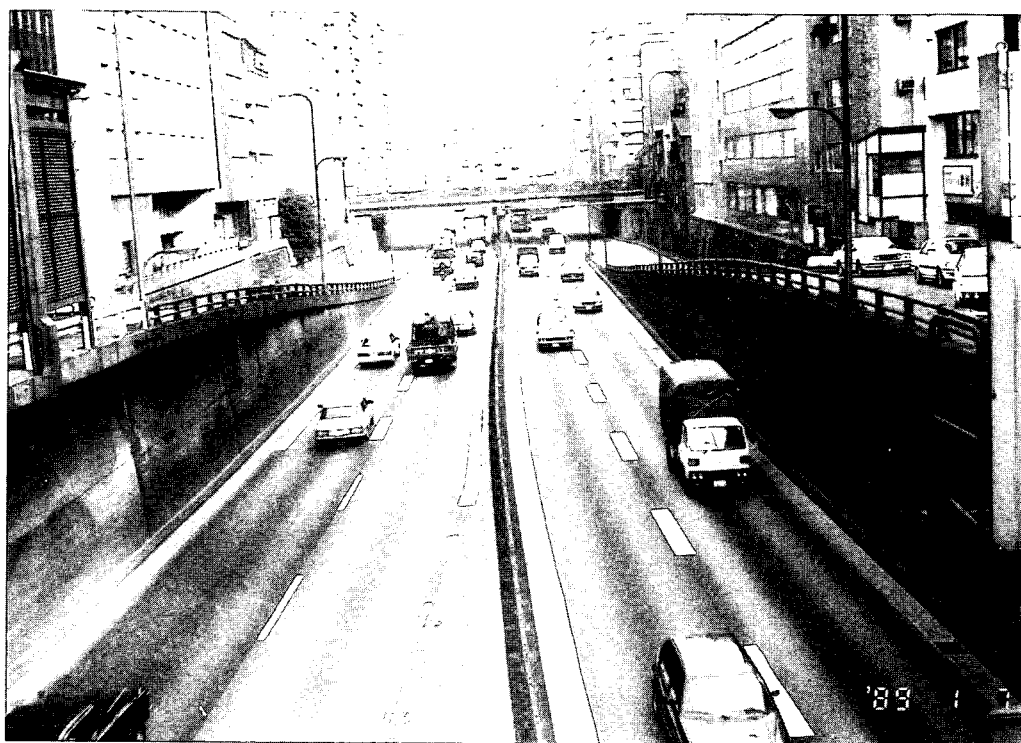
写真 4.6.3 都心を走る掘割道路の例
