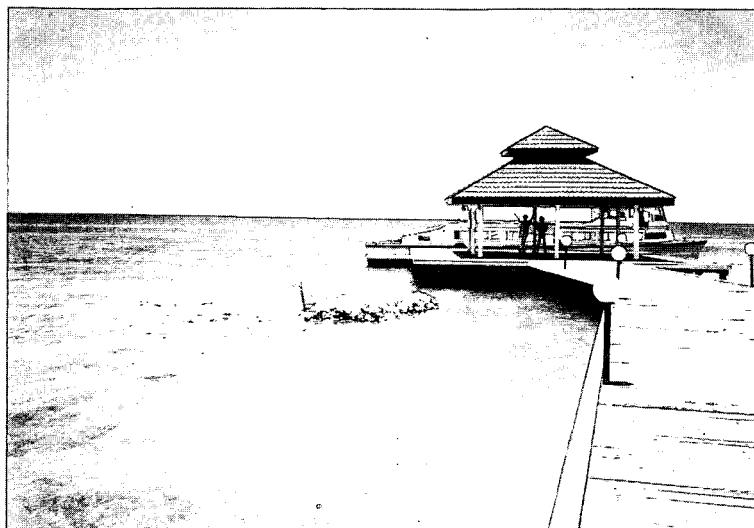
写真－8.8 Krumba 島の栈橋先端部
