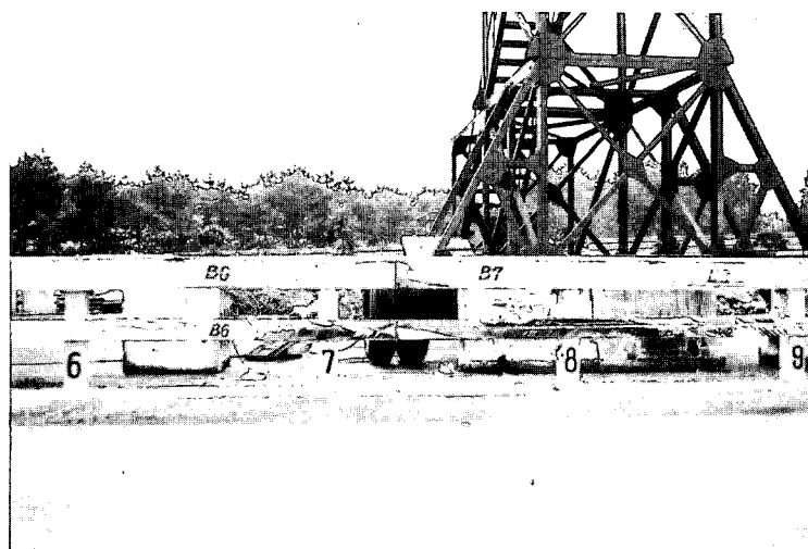
〔写真1-6〕 防護柵の損傷状況（その1）
