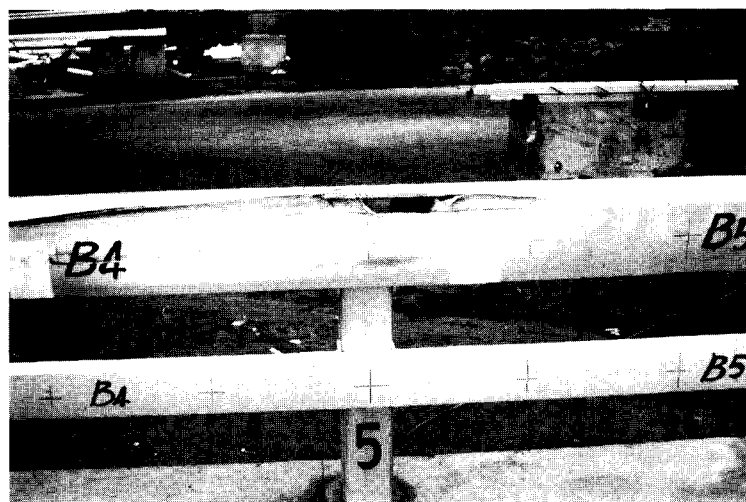
〔写真2-9〕 主要横梁穴あき状況
