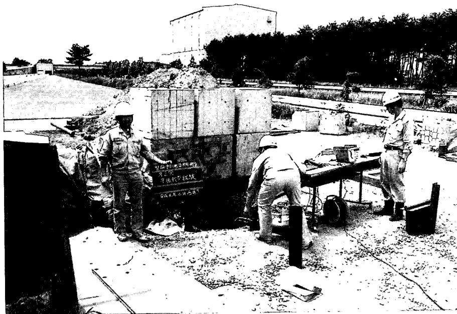
写真-5.1 平板載荷試験状況
