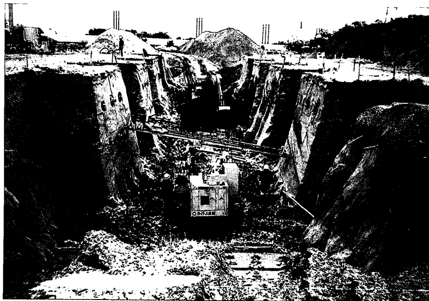
写真-5. 12 削孔状況 (佐貫町)
