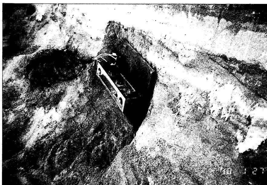
写真－ 5.18 テンション型定着方式の実施例
