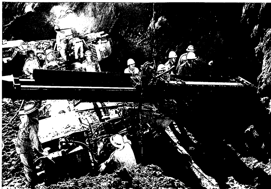
写真-5. 5 削孔状況（栗源町）
