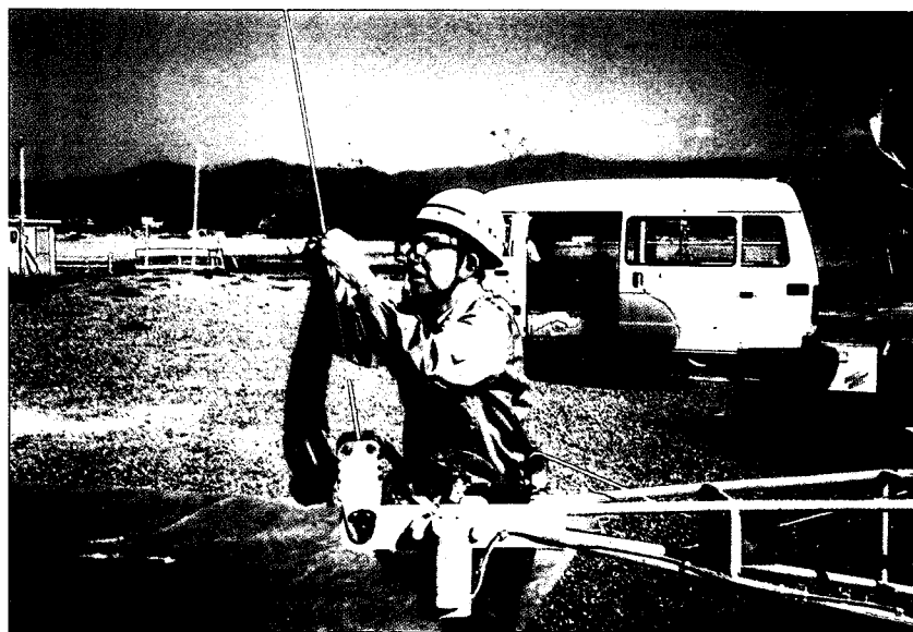
写真-5.6 障害標識の設置(50mごと)
