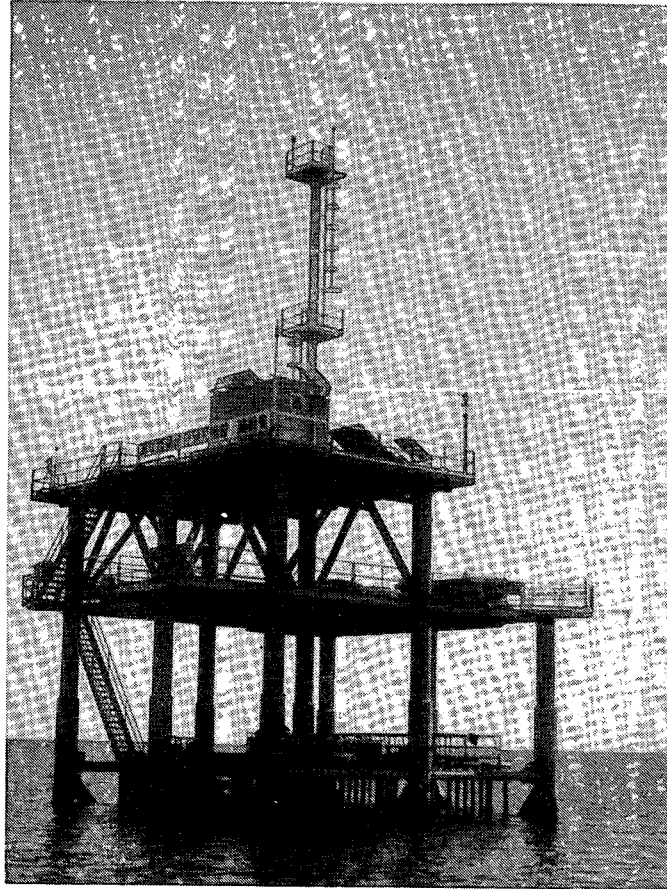
写真－ 3.1 海洋技術総合研究施設
