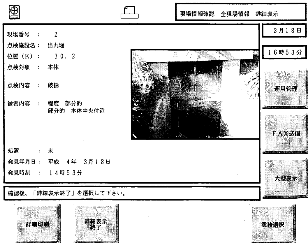
図-3・2・9 CRT表示例（荒川上流工事事務所現場情報）
