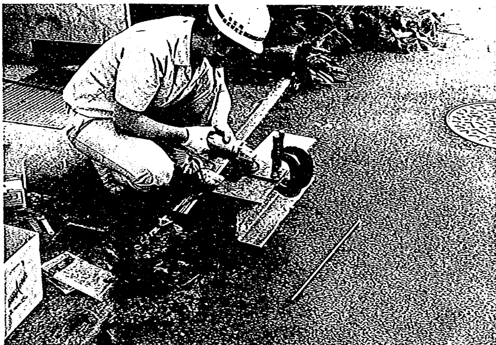
写真-6.3 2種ケレン、ディスクグラインダによる処理
