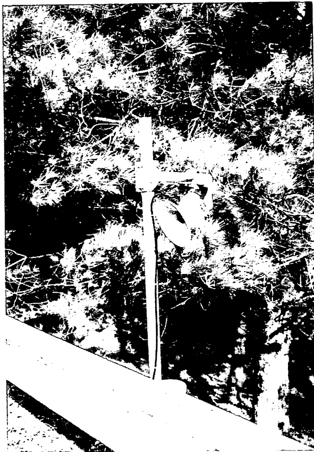
写真 3 - 3 - 4 検知機器（サイドファイア形超音波式車両センサ）
