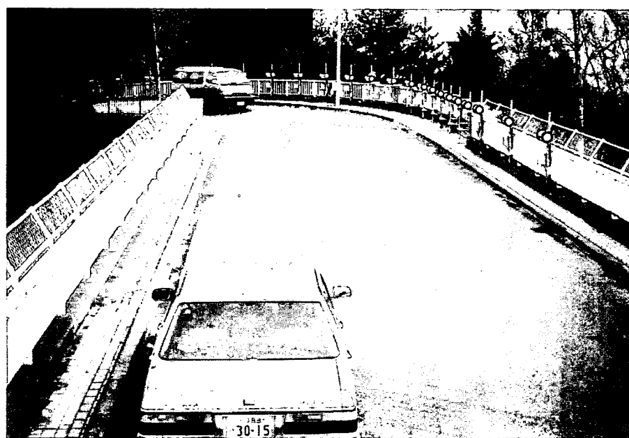
写真 3-3-2 A 3 , A 4 設置状況
