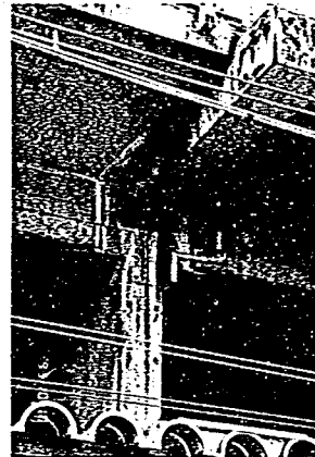
写真5.4 地下鉄駅のホーム。コンクリートから析出した炭酸カルシウムの上に錆汁が付着している。
