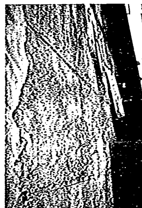
写真6.6 コンクリートブロック塀の補修ムラ。色の違いが明瞭である。
