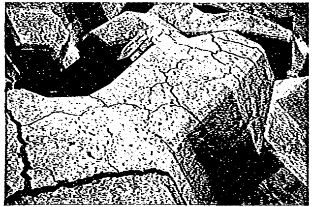
写真7.2 消液ブロックにアルカリ骨材反応によるひび割れができたケース。
