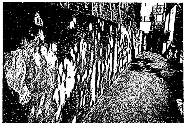
写真6.6 コンクリートブロック塀の補修ムラ。色の違いが明瞭である。
