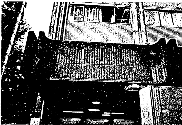
写真2.5 表面のテクスチャーを粗くすると汚れが目立たなくなる。
