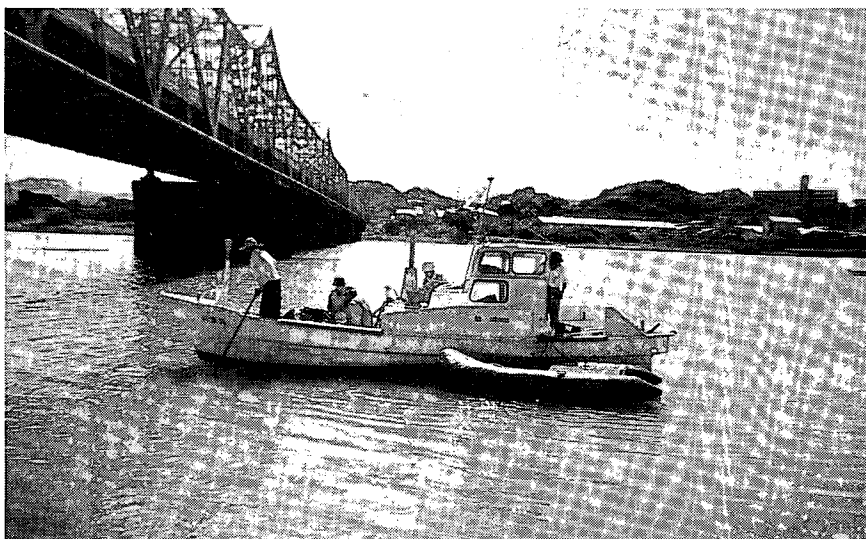
写真-5・10 調査状況
