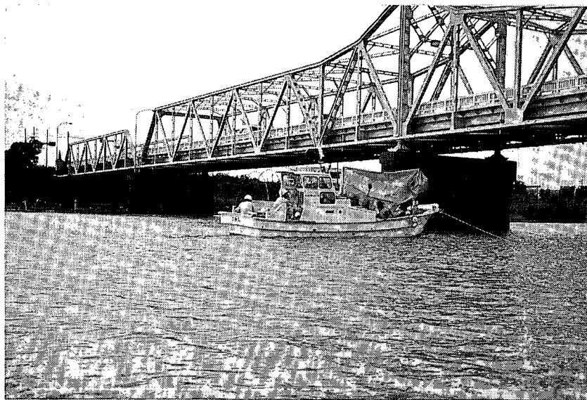
写真－５．１３ 調査状況（下流側から船尾を望む）
