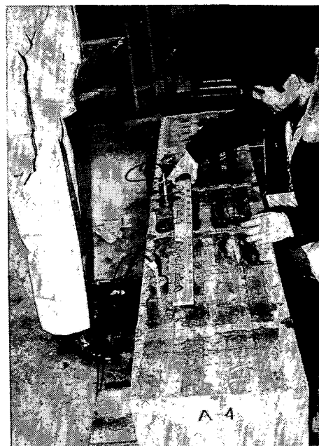
探触子間隔の確認
