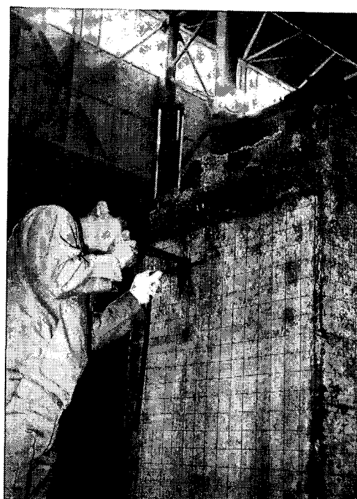
中性化深さ測定
