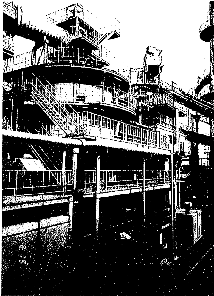
写真3 焼却炉本体とケーキ圧送配管
