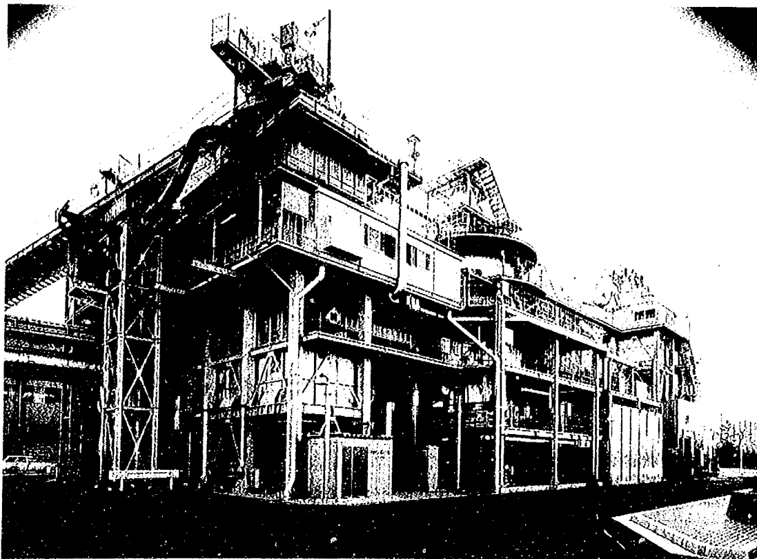
写真1 調査対象流動焼却炉（汚泥投入側より）
