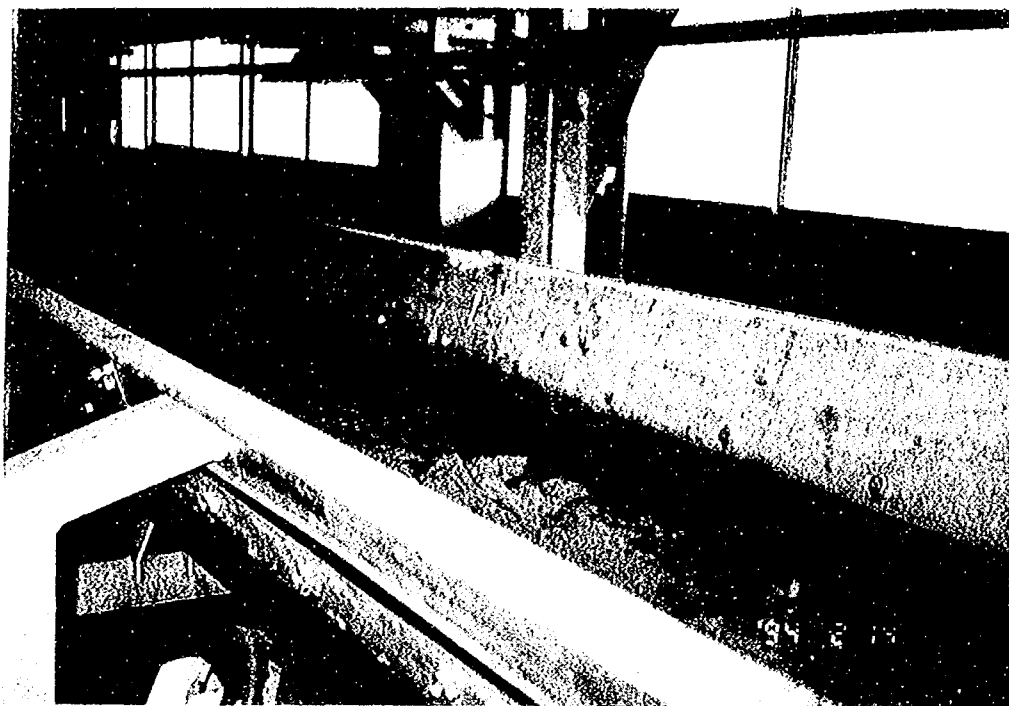
写真7 脱水機棟内コンベア
