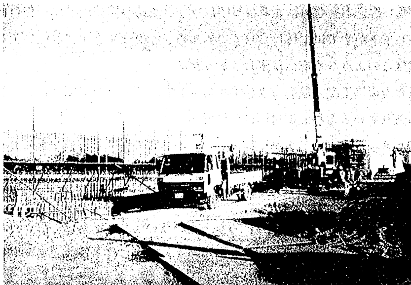
写真－2.3.2 使用重機
