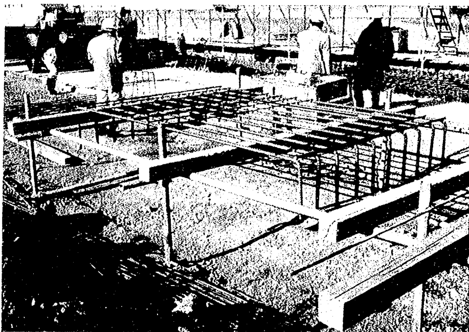
写真-2.3.1 ユニット鉄筋製作架台
