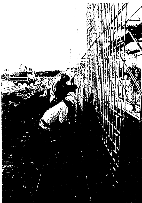
写真-2.3.5 配力鉄筋の接続 (半円形フック付き)
