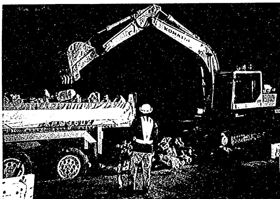
写真-9・4・3 現場の状況
