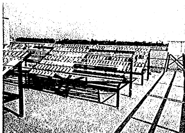
第一デッキ（長期防錆型塗装）
