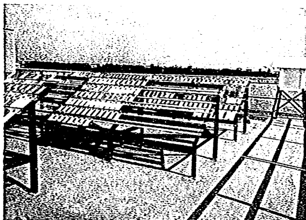
第一デッキ（長期防錆型塗装）
