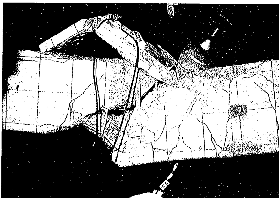
写真-付2 主梁中央部 (C-1、H=2.5m)
