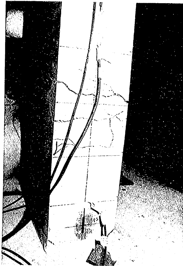
写真-31 柱のひび割れ状況 (C-1、H=2.5m)
