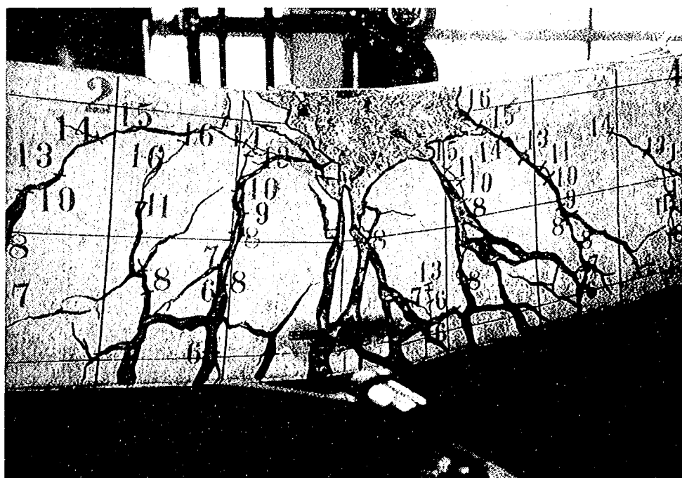
写真-5 主梁部材のスパン中央断面付近のひび割れ様相 (C-1供試体)
