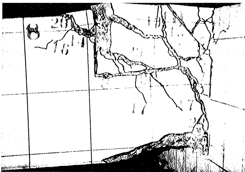
写真-16 主梁・擁壁接合部の様相（C-4供試体）
