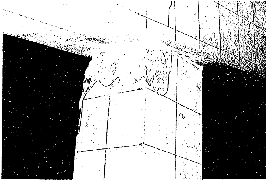
写真-30 主梁と柱の接合部の状況 (C-1K、H=3.5m)
