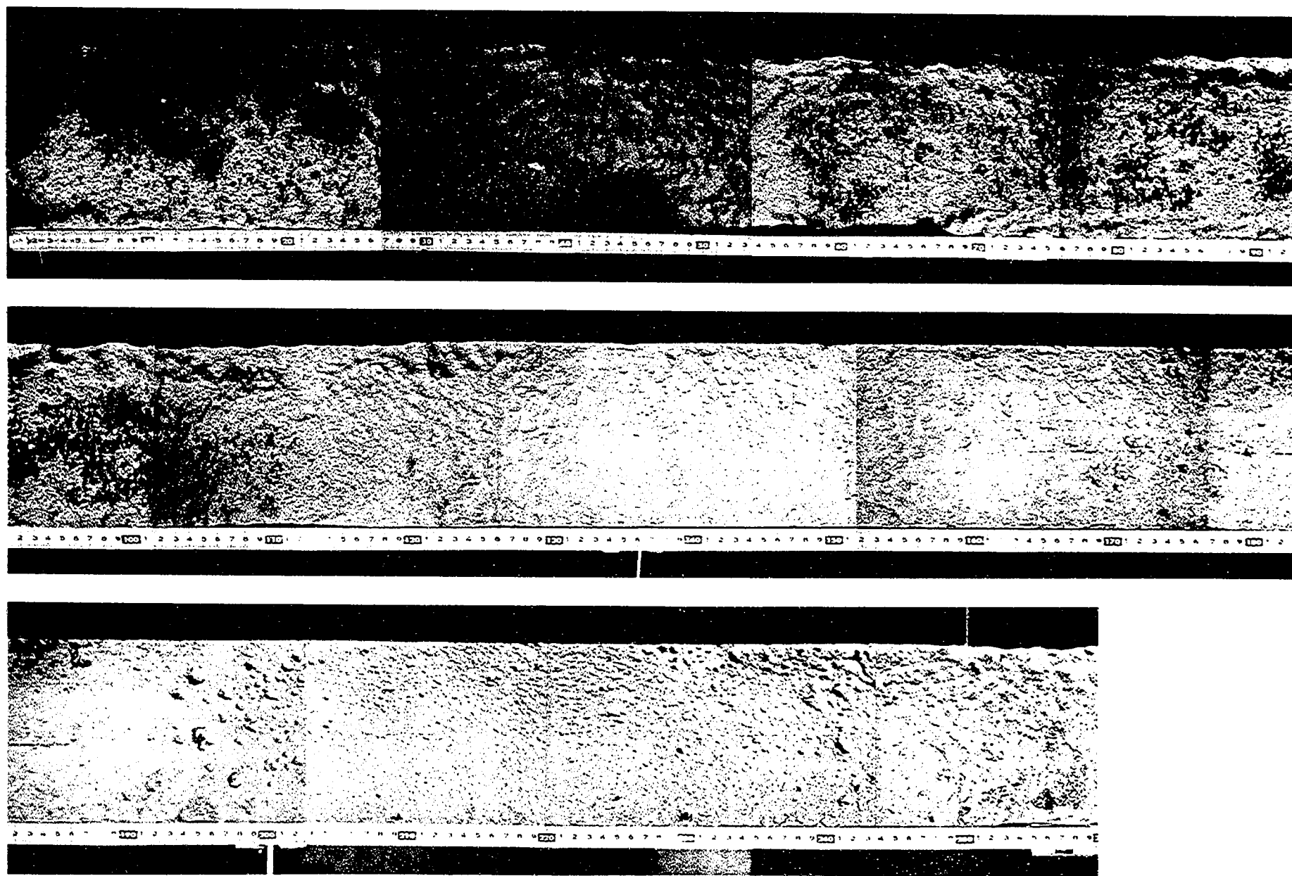
写真-1.3.2(d) 上フランジ腐食状況 (試験体No.5)
