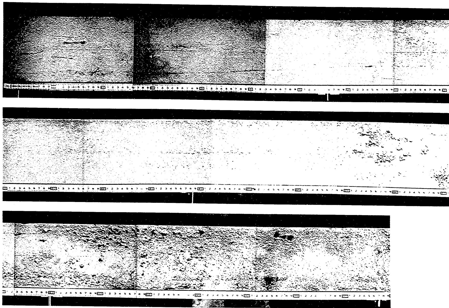
写真-1.3.2(e) 下フランジ腐食状況（試験体No. 6）
