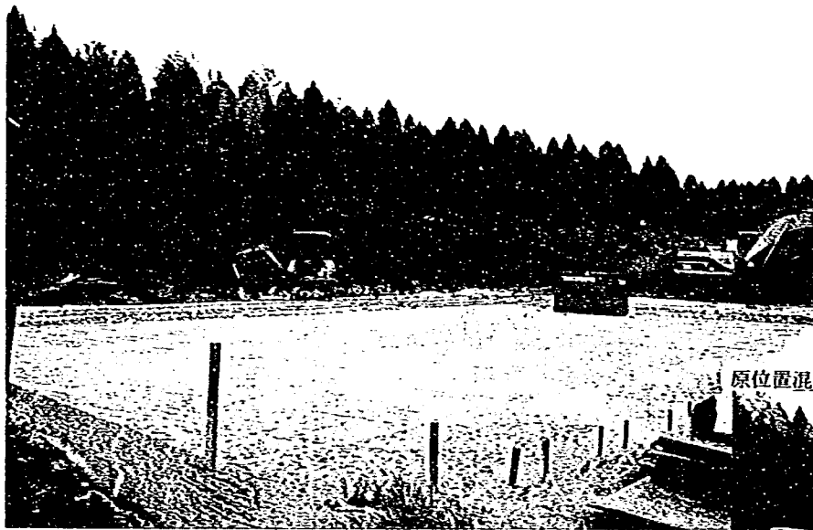
施工場所全景
