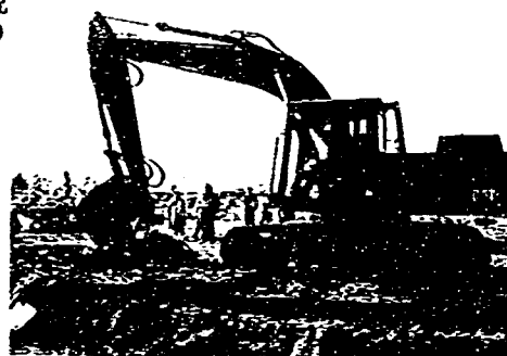
攪拌混合状況 (ハ-ツキ-ダ-)
