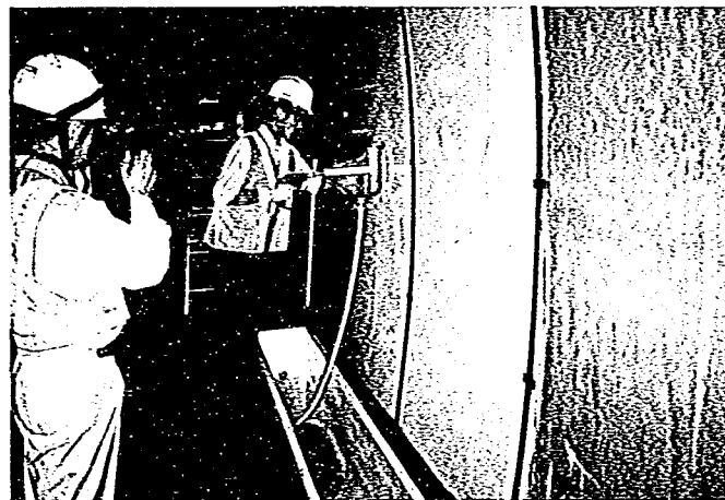
写真-3.3.10トンネル内装板の除去状況 (除去技術A, すすぎ洗浄, 廃液回収)
