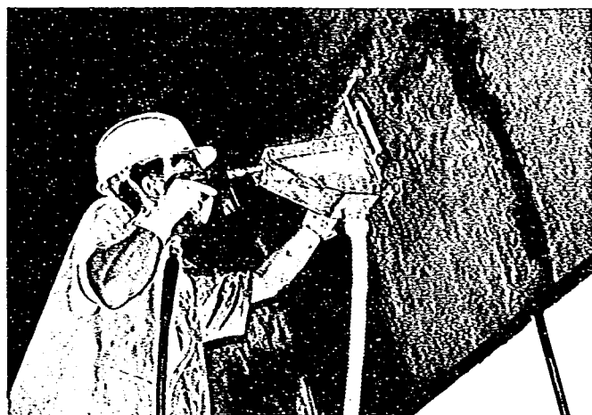
写真-3.3.8トンネル覆工の除去状況 (除去技術A, すすぎ洗浄)
