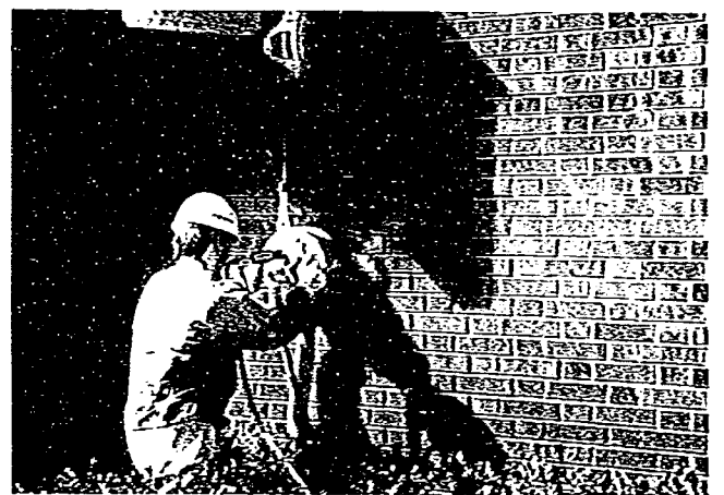
写真-47 レンガ調タイルの除去試験除去中（除去技術C）
