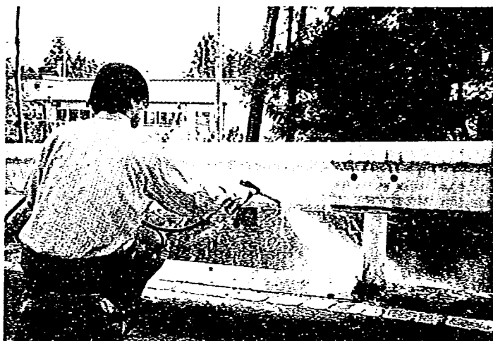
写真-14 ガードレールの除去試験除去中（除去技術A）
