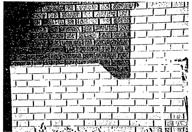
写真-46 レンガ調タイルの除去試験除去前（除去技術C）
