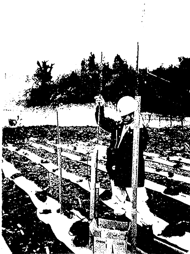
写真-2・3・5 沈下板ロット継足し
