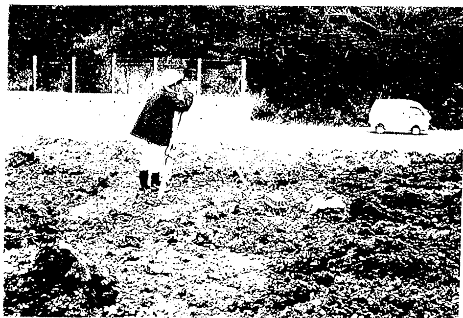
写真-2・3・6 沈下量計測状況
