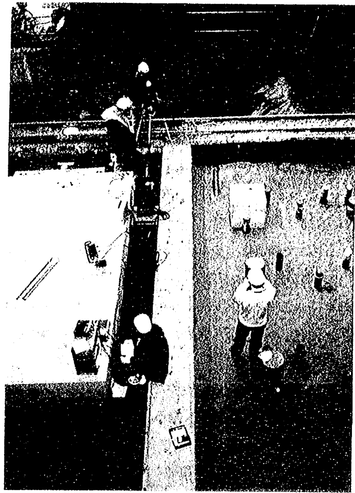
写真-5.3.6 磁気探査状況（斜孔探査）
