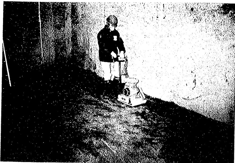
写真-4.5.5 砂の締め固め
