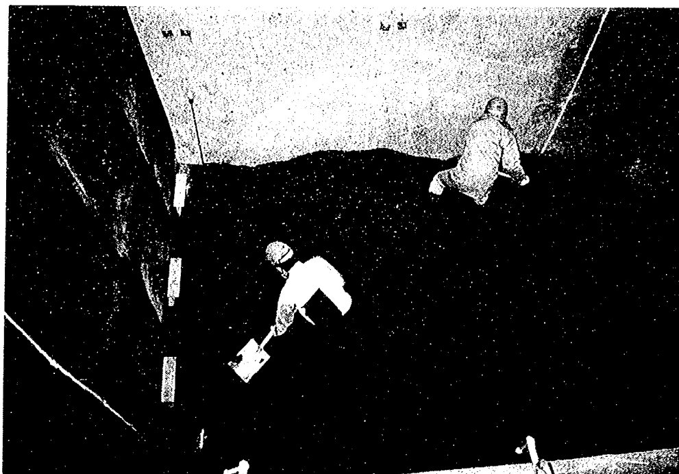
写真-4.5.4 砂の敷き均し
