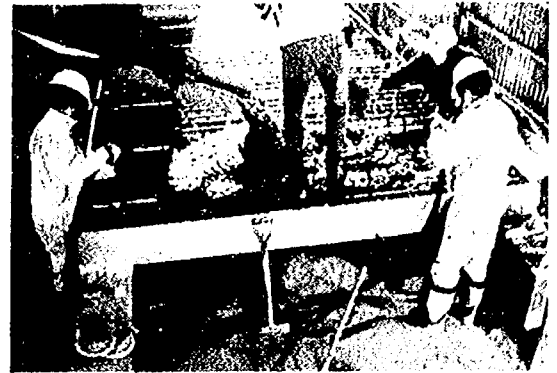
写真-3.2.1.8 コンクリート打設状況 2
