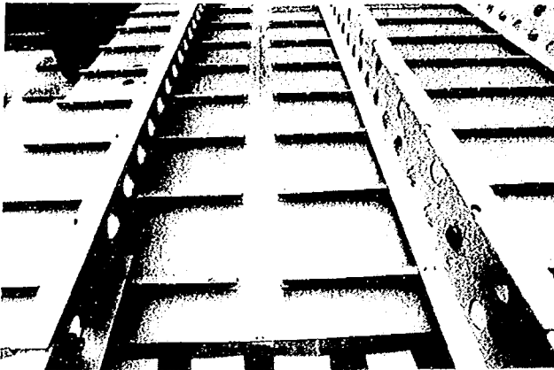
写真-3.2.1.3 パネルの接合部
