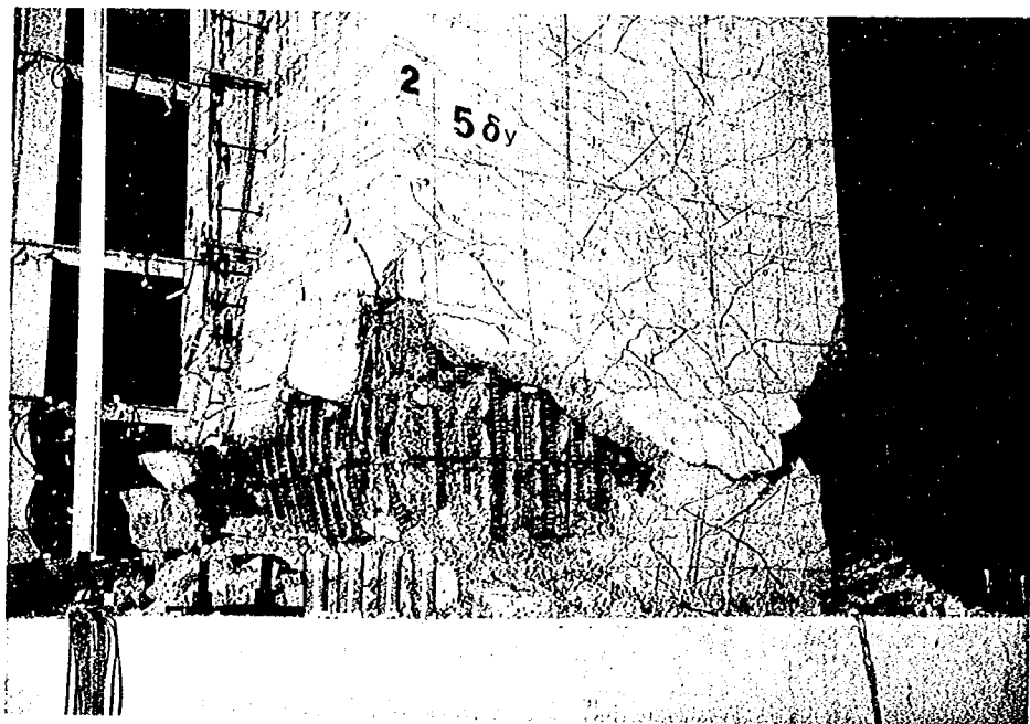
写真-3.11 損傷の上方への進展 ( 5\delta_y )
