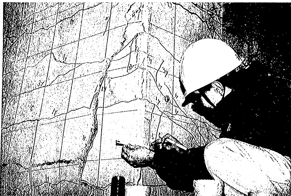
写真-3.6 隅角部における縦方向ひびわれとコンクリートの剥離 ( 3\delta_y-2 サイクル目)
