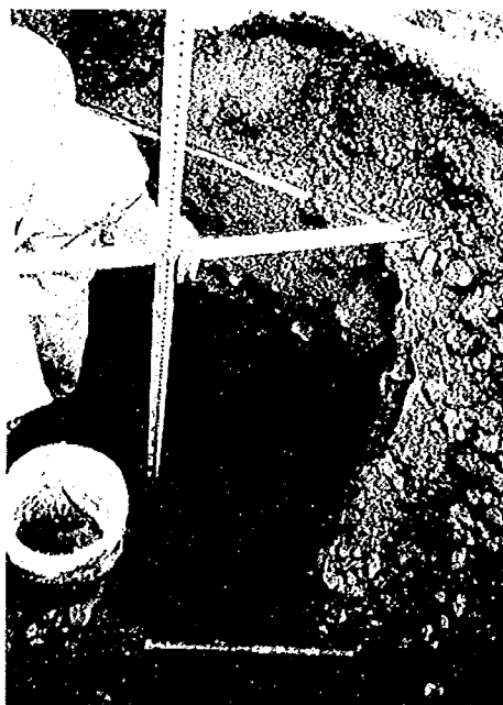
写真-6.3 試掘状況写真
