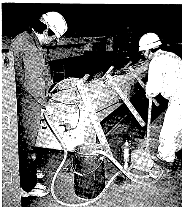
付-1.6 グラウト注入作業状況
