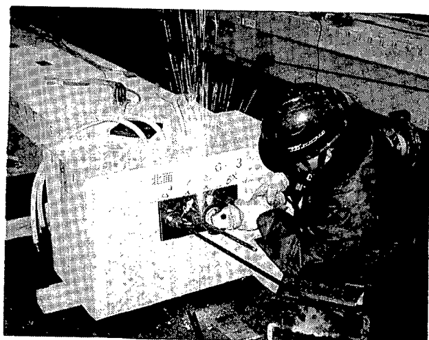
例：G3供試体：PC鋼材緊張完了後グラウト用の グラウトキャップ配置のためのケーブル端部処理 付-1.3 緊張定着完了後の処理
