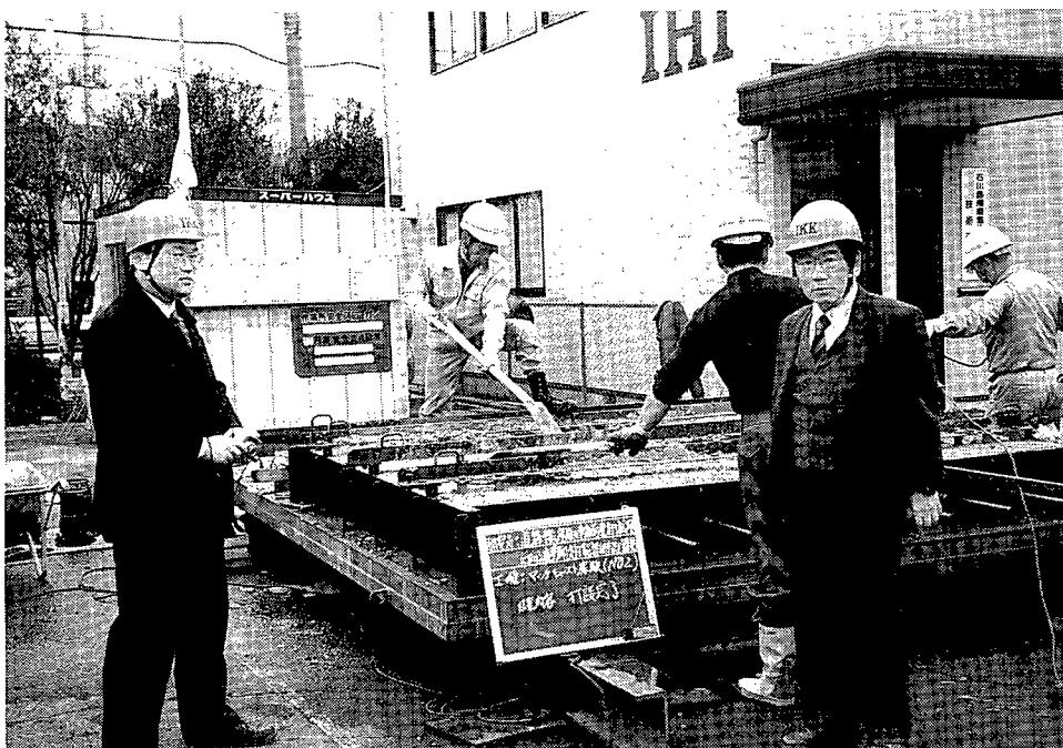
写真-3.2.3.4 供試体Bコンクリート打設
