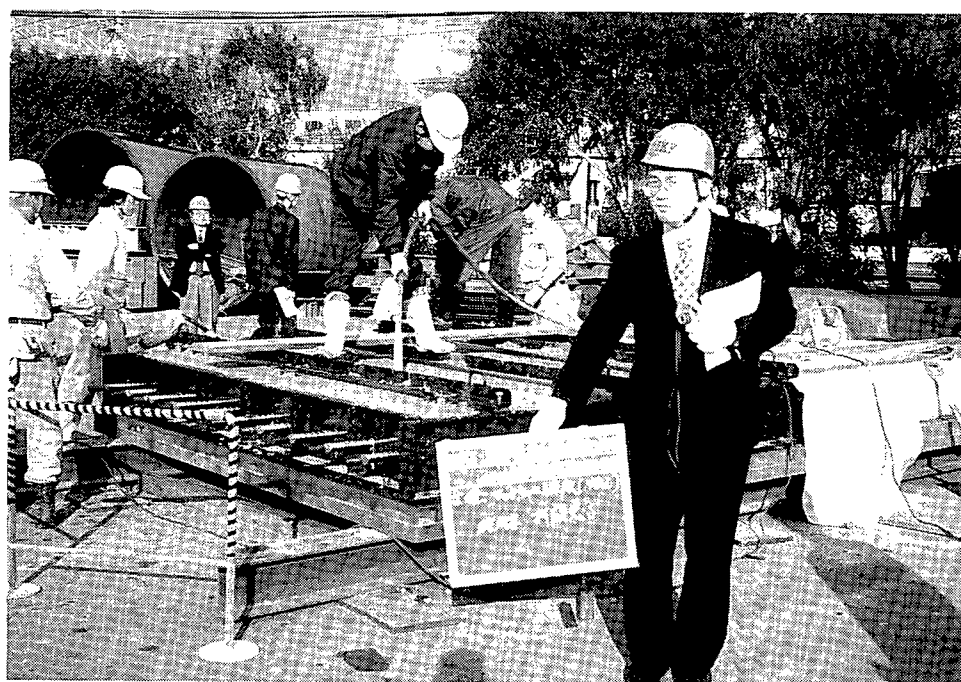
写真-3.2.3.2 供試体Aコンクリート打設
