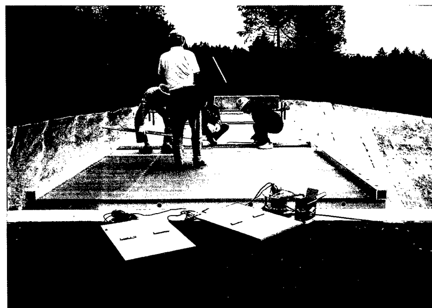
滑り止め板 敷設
