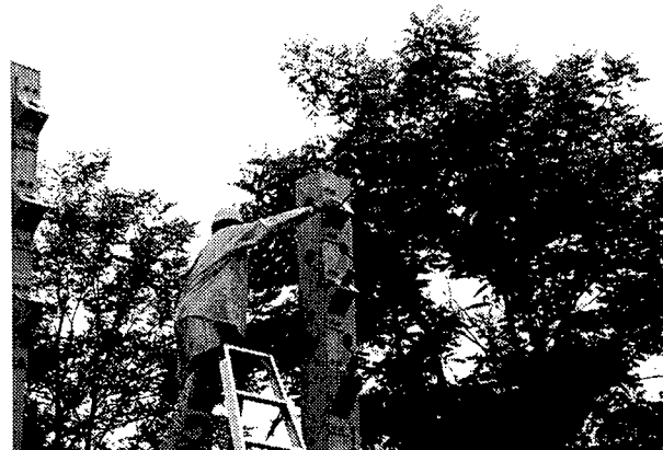
ケーブルの設置
