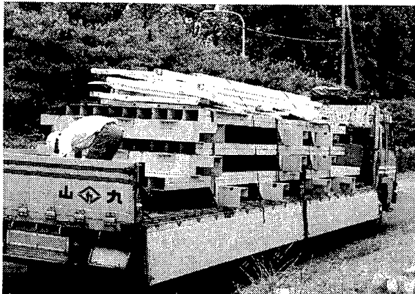
搬出（床版と手摺り）
