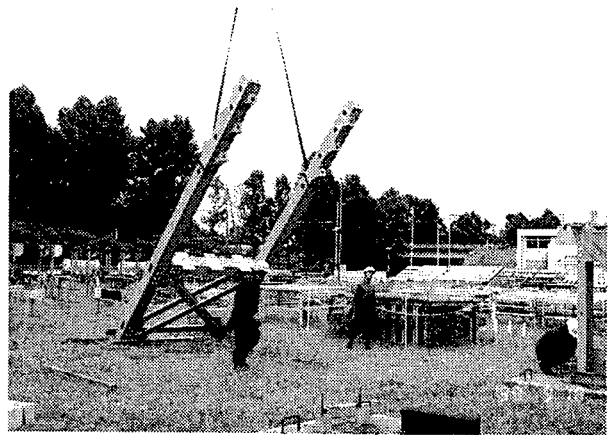
解体作業（タワー）
