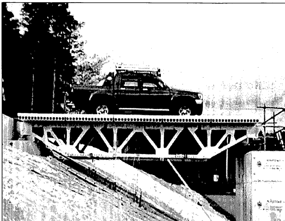
(a) 応急車道橋全景
