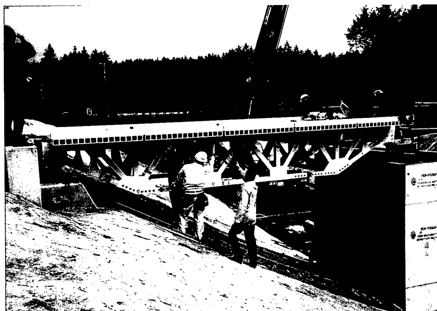
床版 敷設終了
