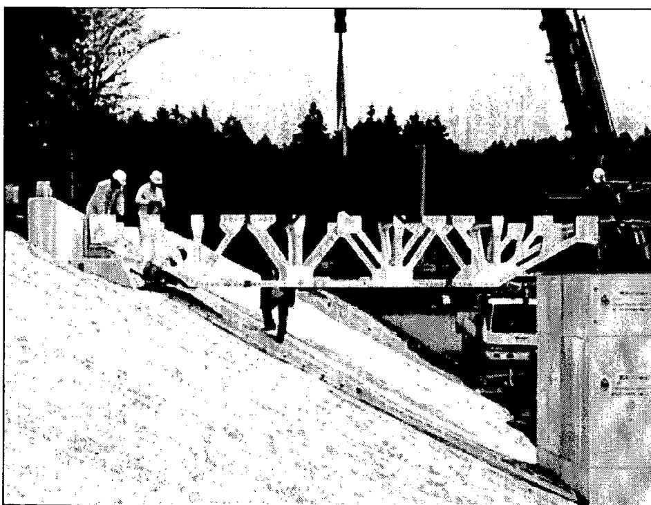
(b) 床組トラス構造（架設状況写真）
