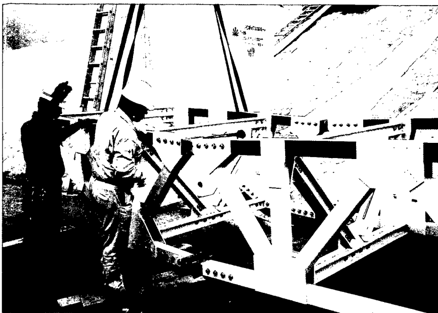
主構 クレーンによ る組立て
