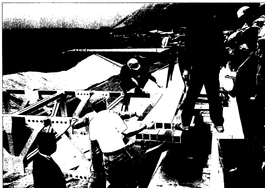
主構 ハンドリフト による敷設
