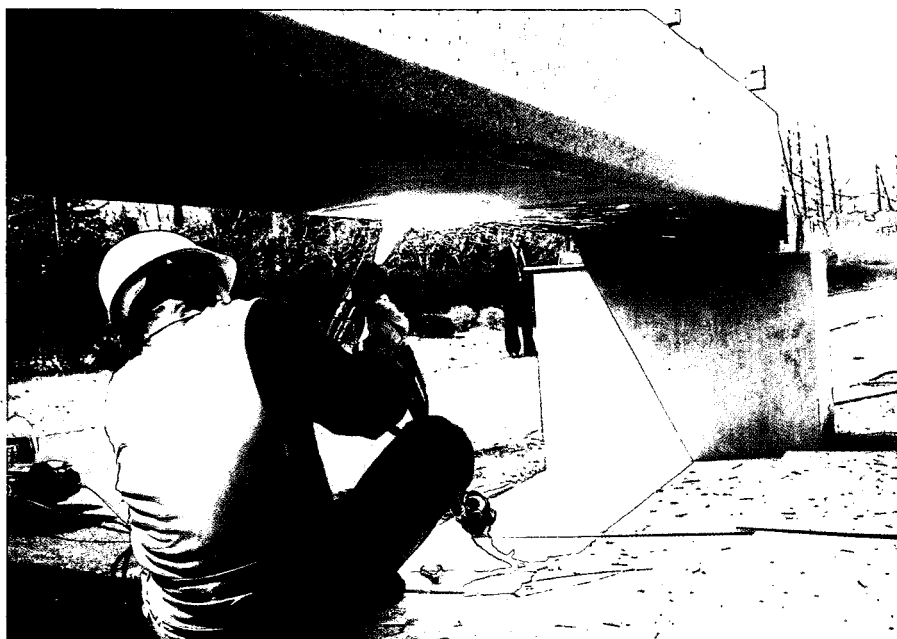
PC（プレテン）大型供試体 チタン溶射方式 陽極 施工状況
