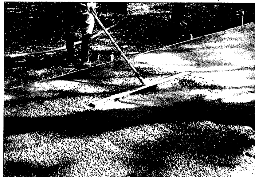
写真 9 敷均し状況（普通ポルトランドセメント）
