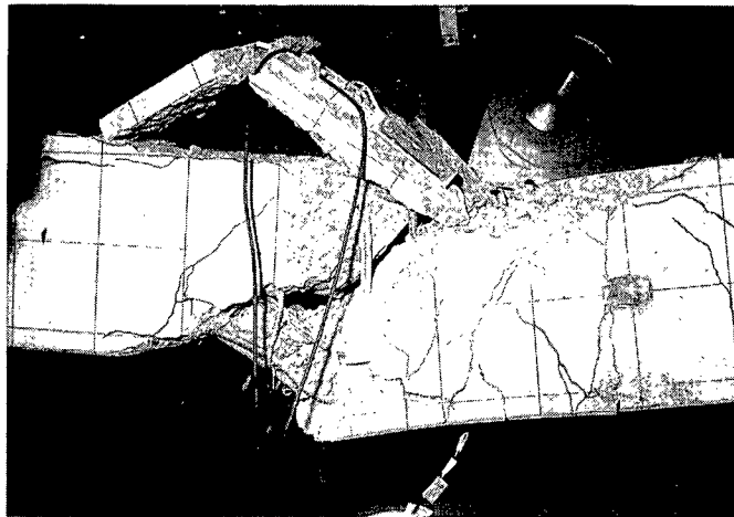
写真－ 3 . 4 . 1 主梁中央部の破壊状況(C-1)
