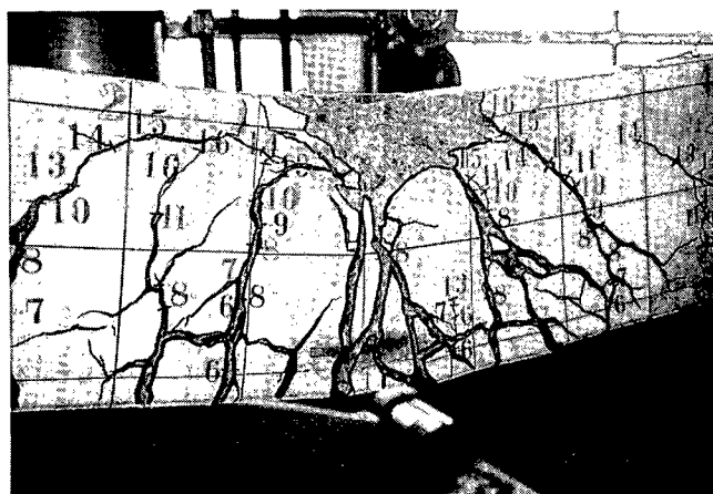
写真－2. 2. 1 C－1 主梁部材スパン中央部断面付近の破壊状況
