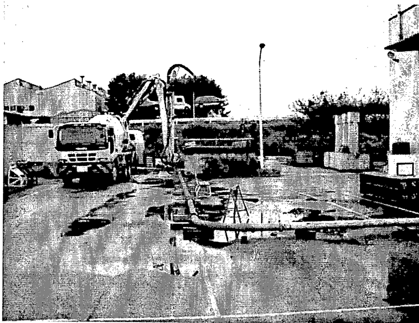
写真－５ 配管２の配管状況（ポンプ車からの水平圧送箇所）
