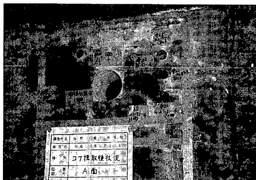
写真-5.3 A面コア採取後状況
