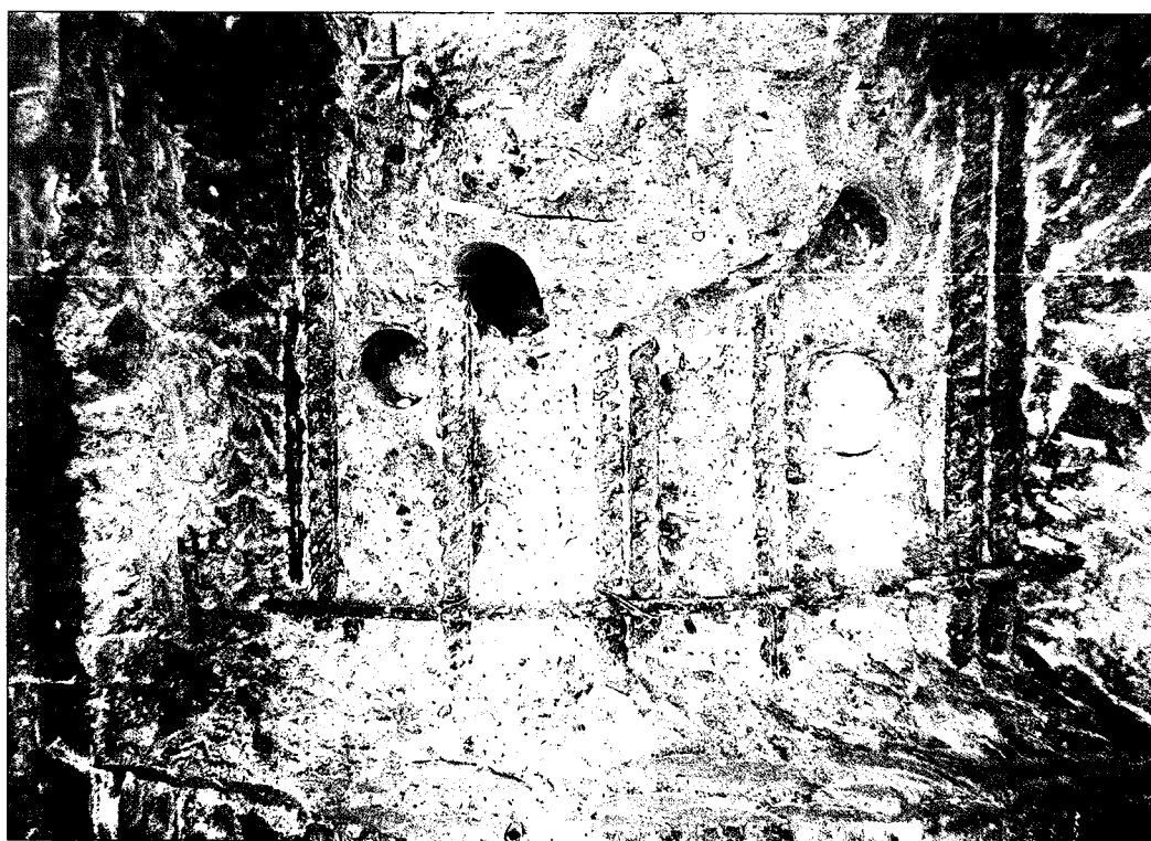
写真－ 6. 4. 2 A面はつり後状況拡大（旧暮坪陸橋 P 3 橋脚）
