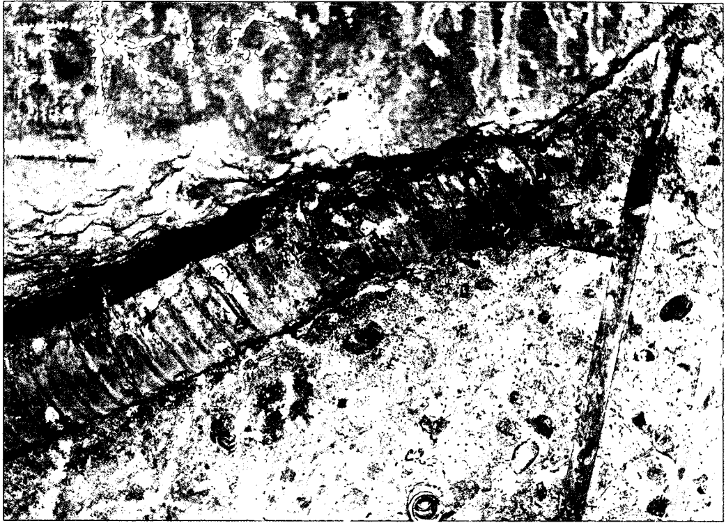
写真－7.4.7 腐食状況－B面調査箇所左上部のシース（旧芦川橋G1桁）
