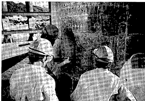
写真－6.4.1 はつり調査状況 1/2
