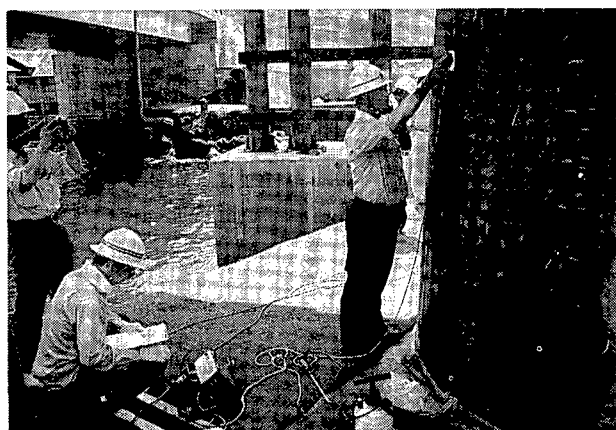
写真－3.4.1 腐食診断状況（Tk法）
