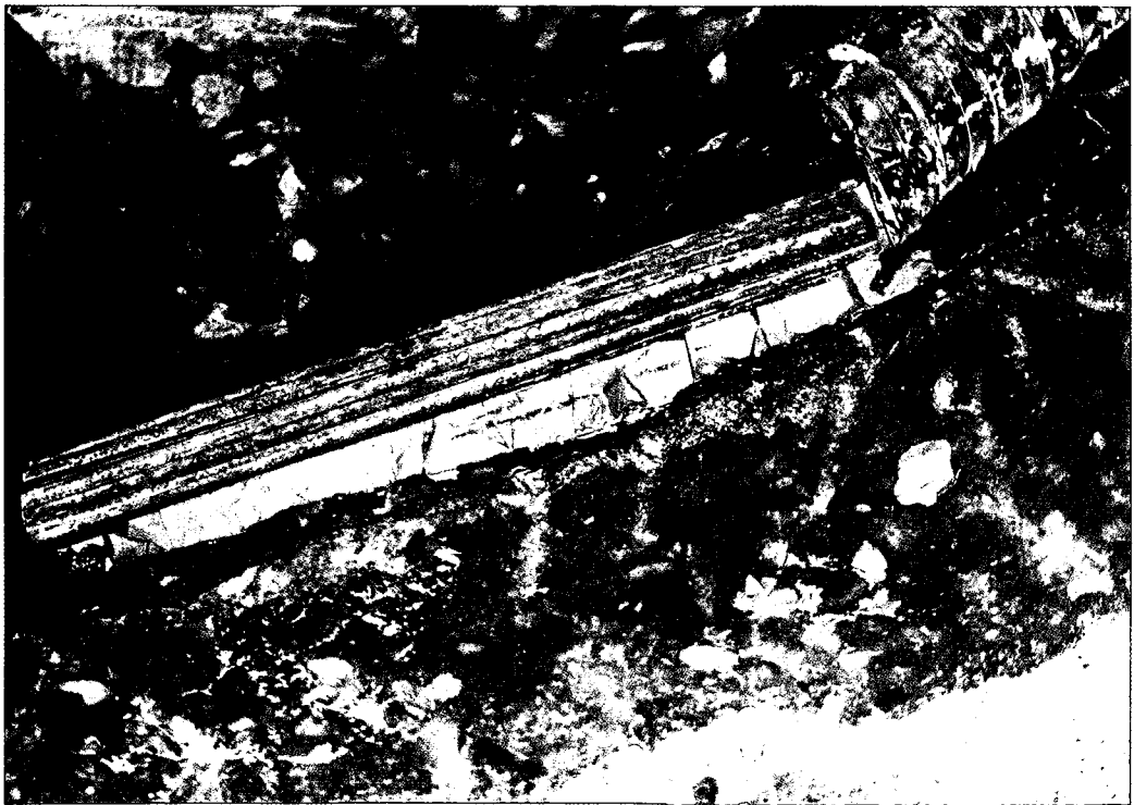
写真－7.4.8 シース内のPC鋼線は健全－B面調査箇所左上部（旧芦川橋G1桁）
