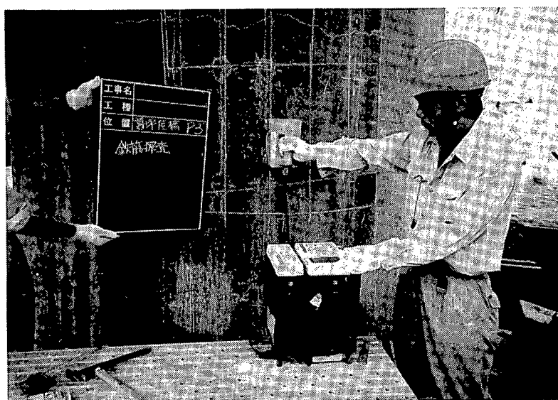
写真－2.2.1 測定状況（D k 法）
