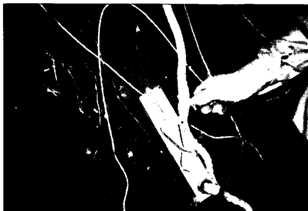
図2.5-5 挟み付け固定によるファイバセンサの布設
