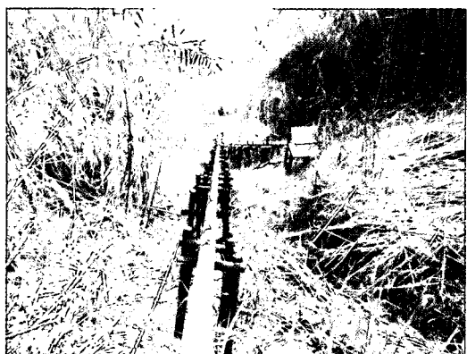
写真3-20 保護管の例(地上架設)
