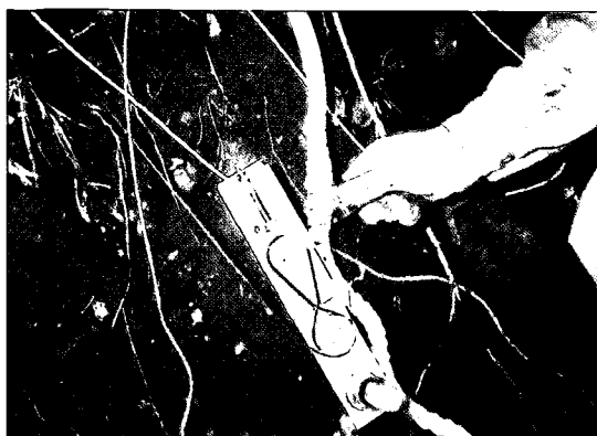
写真 3-22 設置後の保護 チューブ取付例
