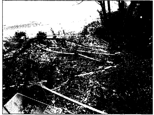
写真3-13 地表面布設例
