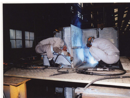
Step-4の溶接状況
