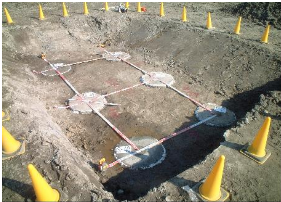
写真4.2.4 杭頭出来形(軸間距離 2,500 mm)
