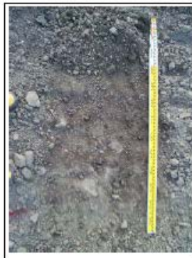
転圧後の盛土材（転圧回数：5回）
