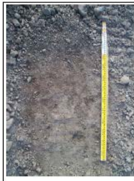
転圧後の盛土材（転圧回数：12回）
