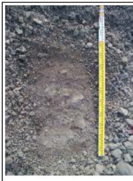
転圧後の盛土材（転圧回数：8回）
