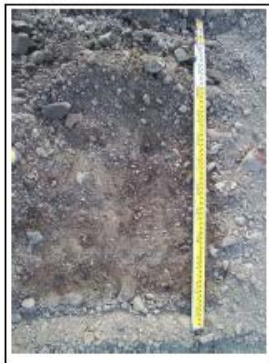
転圧後の盛土材（転圧回数：3回）
