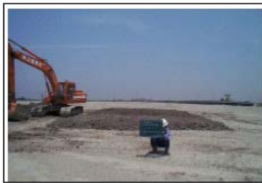
盛土材敷きだし後（敷きだし厚：約35cm）
