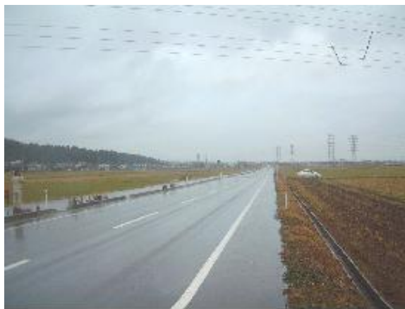
地震後の現地状況写真
