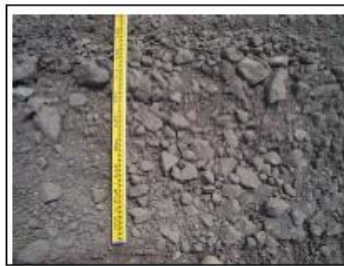
転圧前の盛土材（最大粒径5～10cm）
