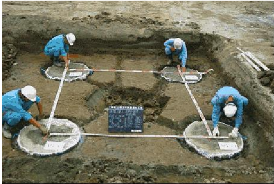
写真4.2.3 杭頭出来形(軸間距離 2,800 mm)
