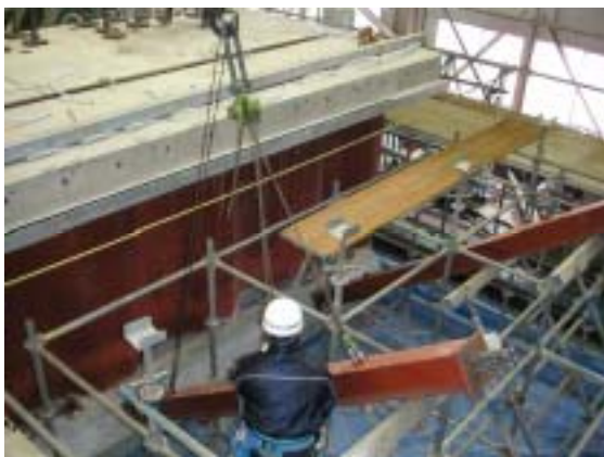
写真-3.3.1 ストラット架設状況
