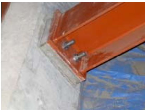
写真-3.4.9 下部接続部
