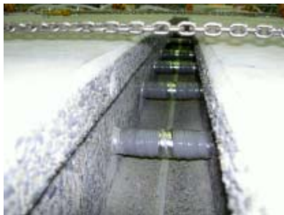
写真-3.4.6 橋軸方向シース接続
