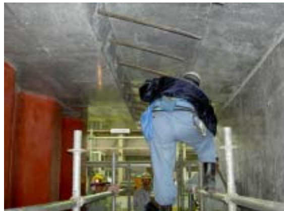
写真-3.3.6 PC鋼材挿入
