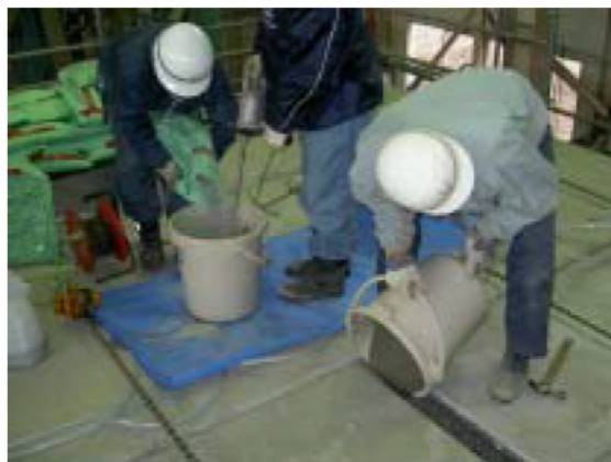
写真-3.4.4 練混ぜ充填状況
