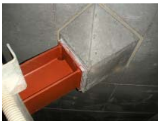
写真-3.4.8 上部接合部
