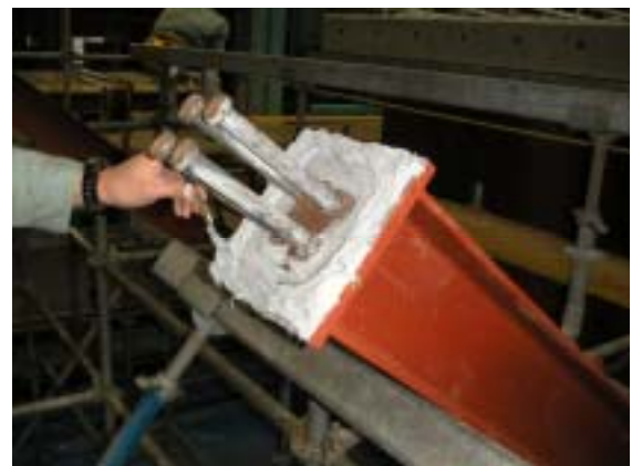
写真-3.3.2 ストラット角度調整
