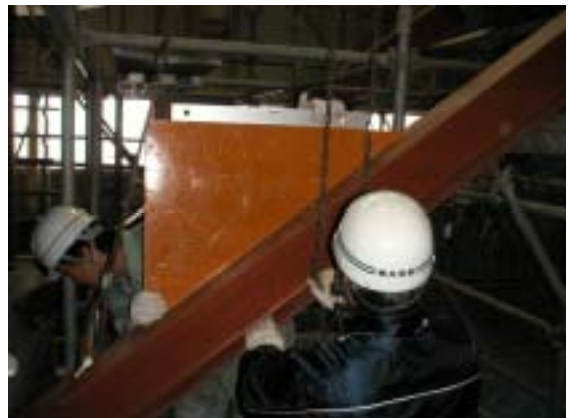
写真-3.4.1 ストラットの角度調整状況
