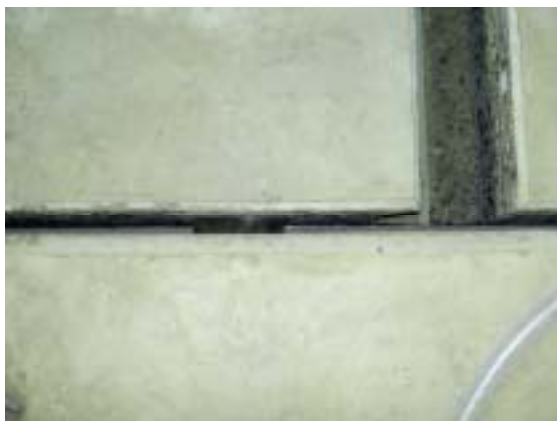
写真-3.4.5 接続スポンジ圧縮状況
