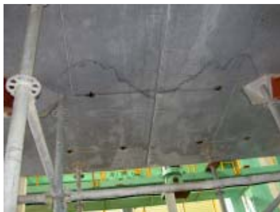
写真-3.4.17 床版下面
