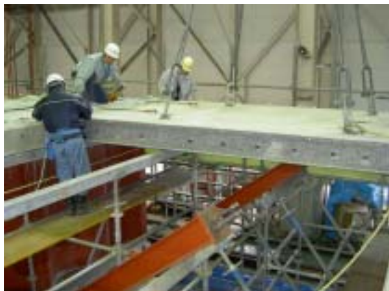
写真-3.3.3 張出しセグ架設状況1
