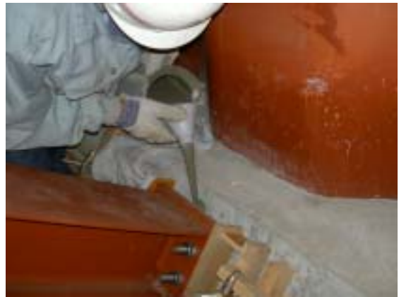
写真-3.3.8 無収縮モルタル充填
