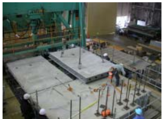
写真-3.3.4 張出しセグ架設状況2
