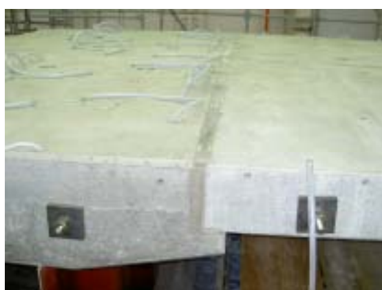
写真-3.4.10 床版接合部
