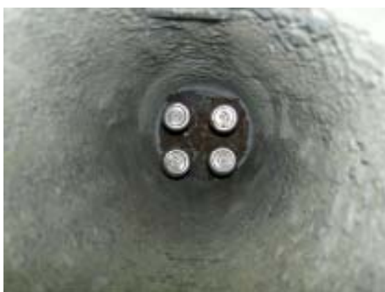
写真-3.4.7 上部接合部（箱抜き孔より）
