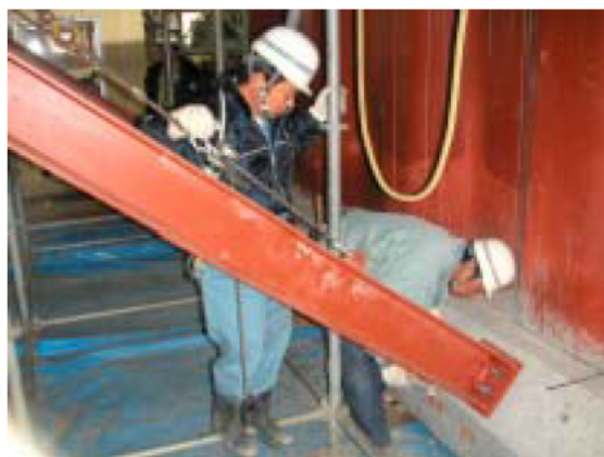
写真-3.4.3 ストラット位置調整状況
