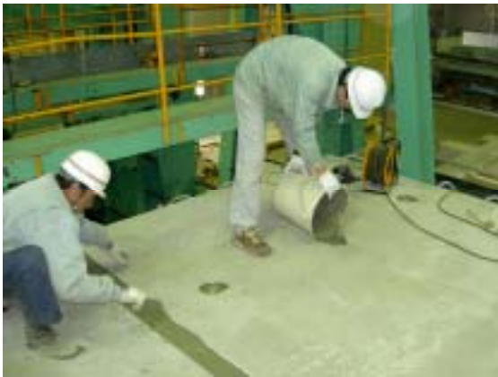
写真-3.3.7 無収縮モルタル充填
