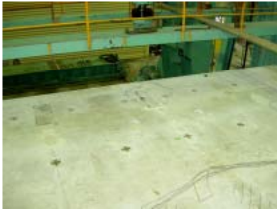
写真-3.4.15 床版上面（全景）
