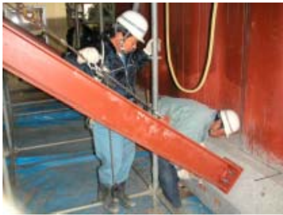
写真-3.3.5 ストラット位置調整
