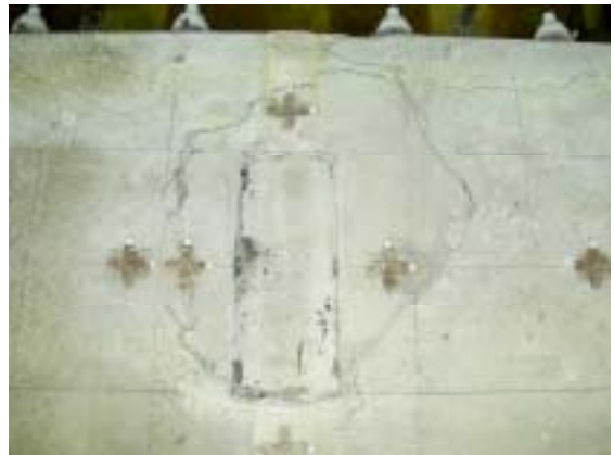
写真-3.4.16 床版上面（載荷位置）
