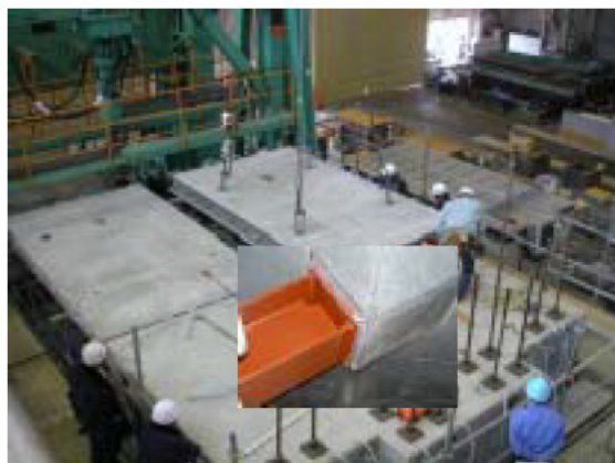
写真-3.4.2 張出し床版架設状況
