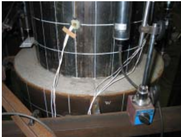
写真-4.2.5 A-2 試験体 (引抜き) 実験後のコンクリート面の状況
