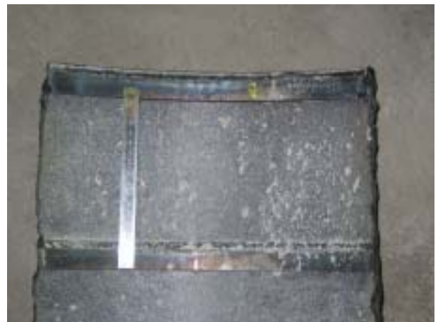
(b) 外鋼管のずれ止め(片側隅肉)の状況(損傷なし)
