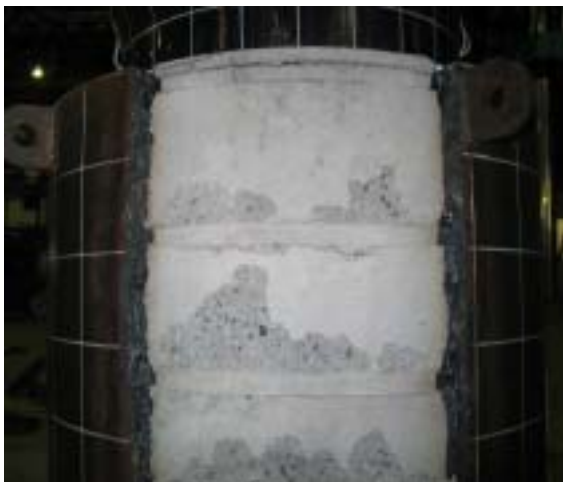
(a) 内部コンクリートの状況
