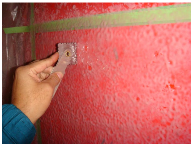
写真解-9 ウェットフィルムゲージによる 塗付量の確認
