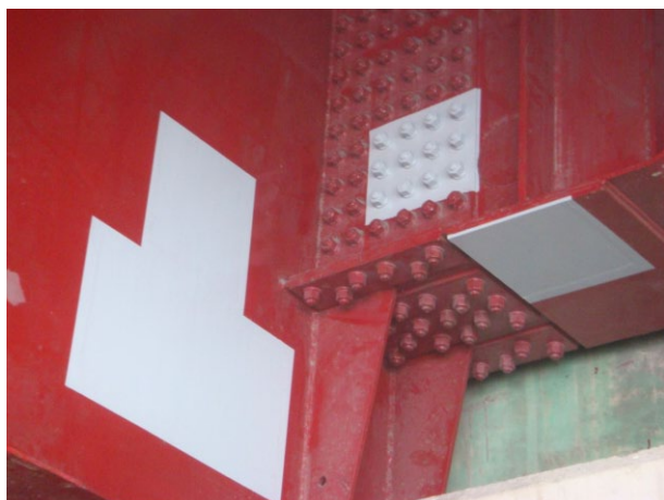
写真解-13 試験箇所の復旧
