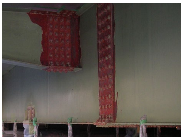
写真解-51 連結部を先行はく離した例
