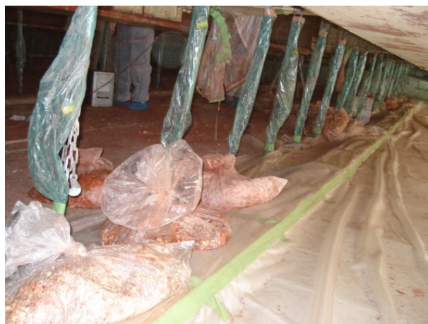
写真解－53 仮集積状況
