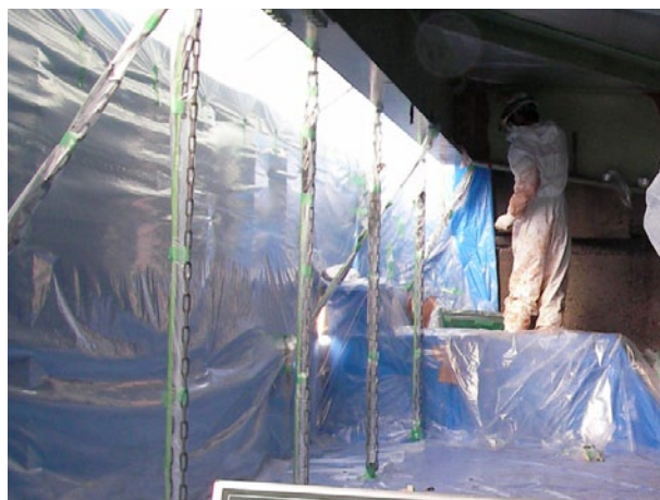
写真解-24 逸散防止フィルム養生
