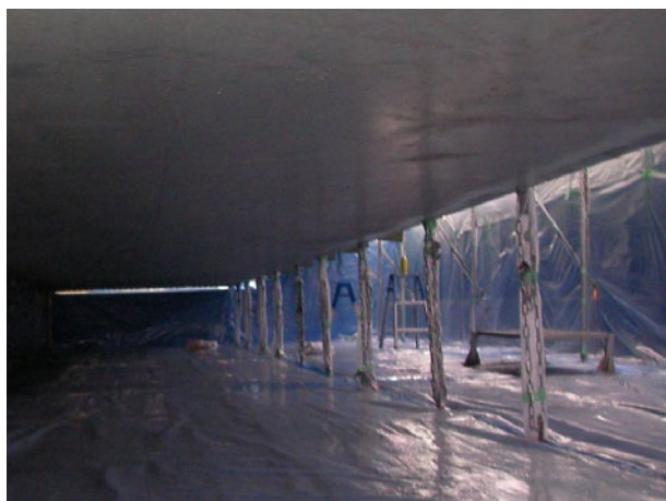
写真解-23 飛散防止養生シート
