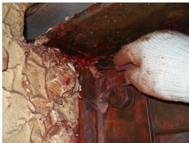
写真解－45 狭隘部の塗膜除去
