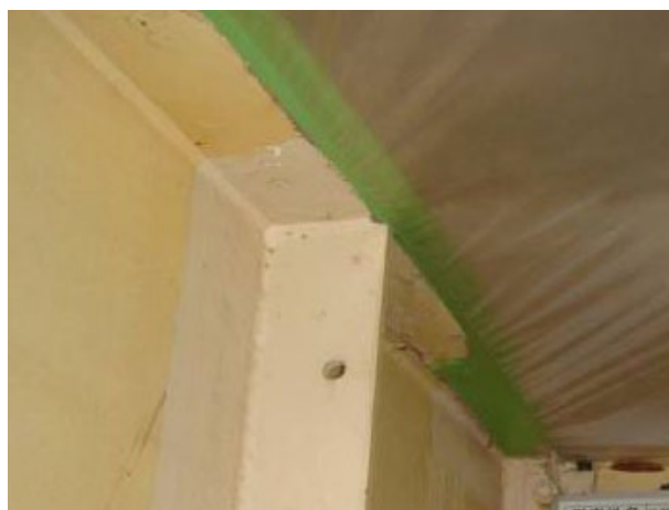
写真解-26 コンクリート床版の養生
