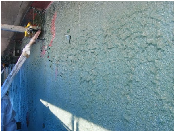
写真解－33 上層塗膜が細かく縮んだ例
