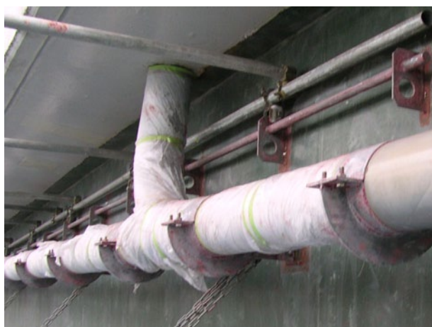
写真解-25 塩化ビニル製排水管の保護養生
