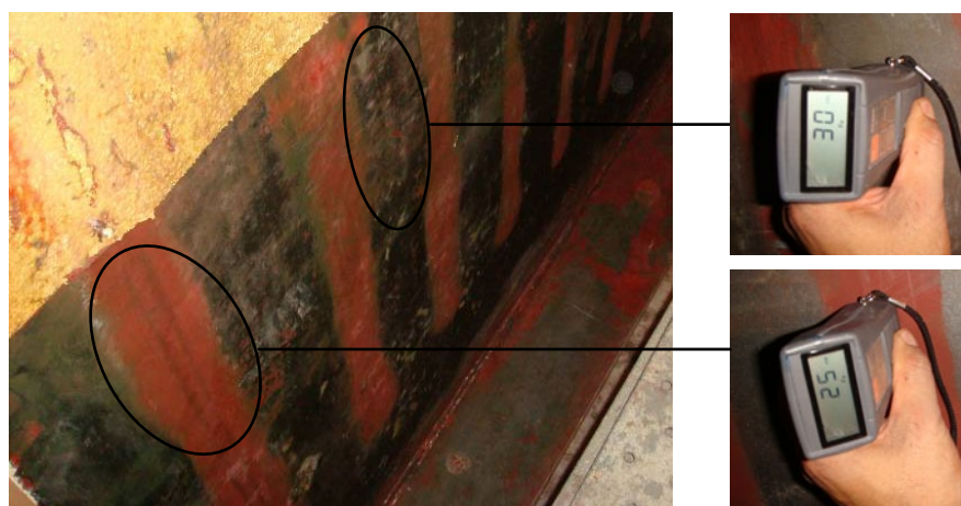
写真解－55 塗膜除去程度の確認の例
