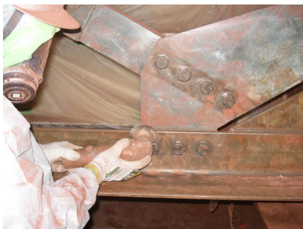
写真解－46 連結部の塗膜除去
