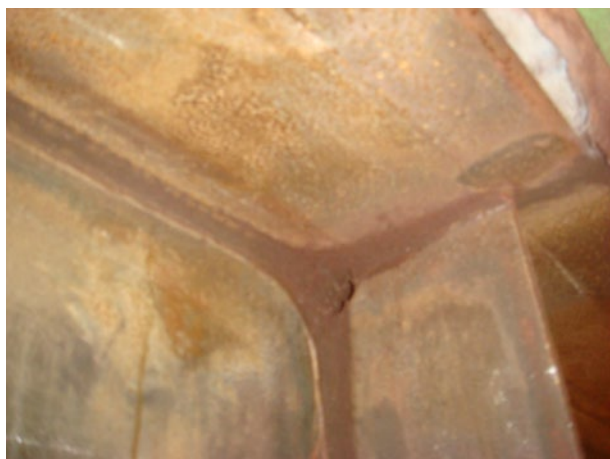
写真解-49 軟化塗膜を除去し残した例
