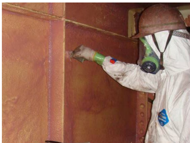
写真解－32 ウェットフィルムゲージによる塗付量確認
