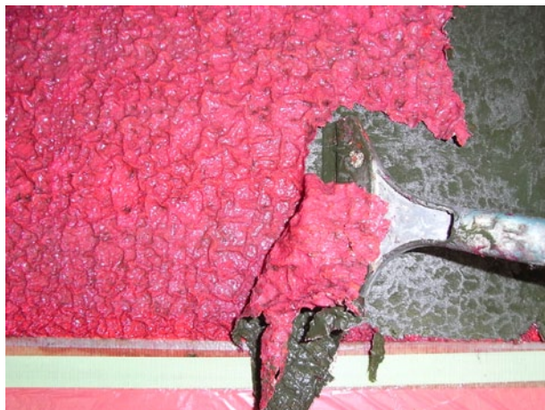
写真解-11 スクレーパーによる塗膜除去
