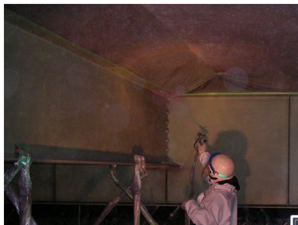
写真解-30 インバイロワン塗付の状況
