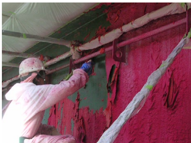
写真解－44 腹板の塗膜除去
