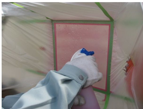
写真解-8 インバイロワン塗付
