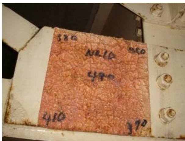
写真解-16 B塗装系塗膜の軟化状態
