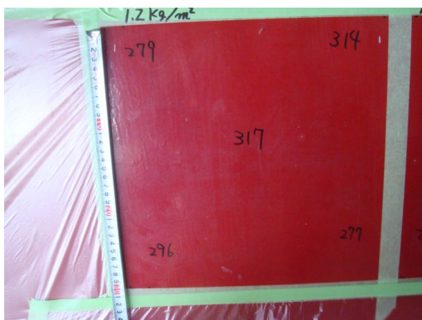
写真解-7 養生・塗膜厚測定
