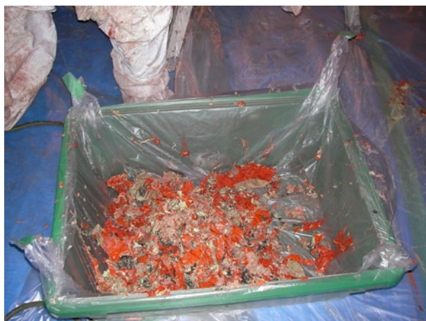
写真解－52 除去塗膜の回収
