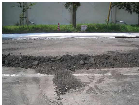
写真 6.1-2 工区断面（現況）
