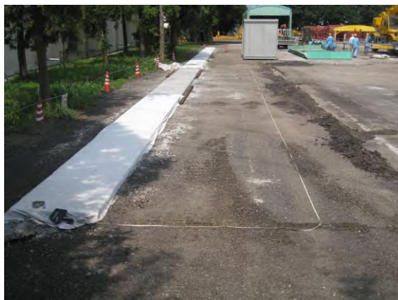
写真 6.1-1 工区全景（現況）
