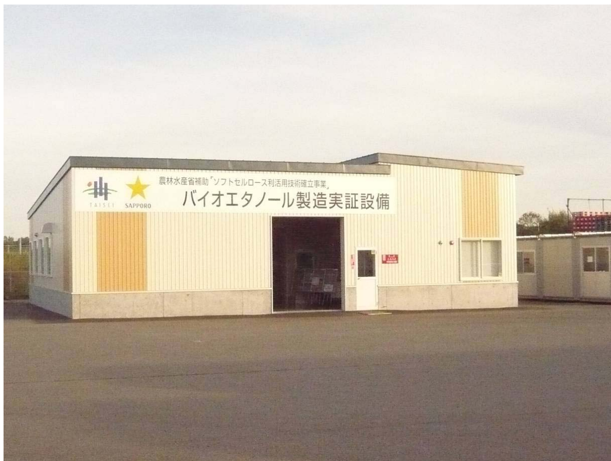
図 5－2 バイオエタノール製造実証施設
